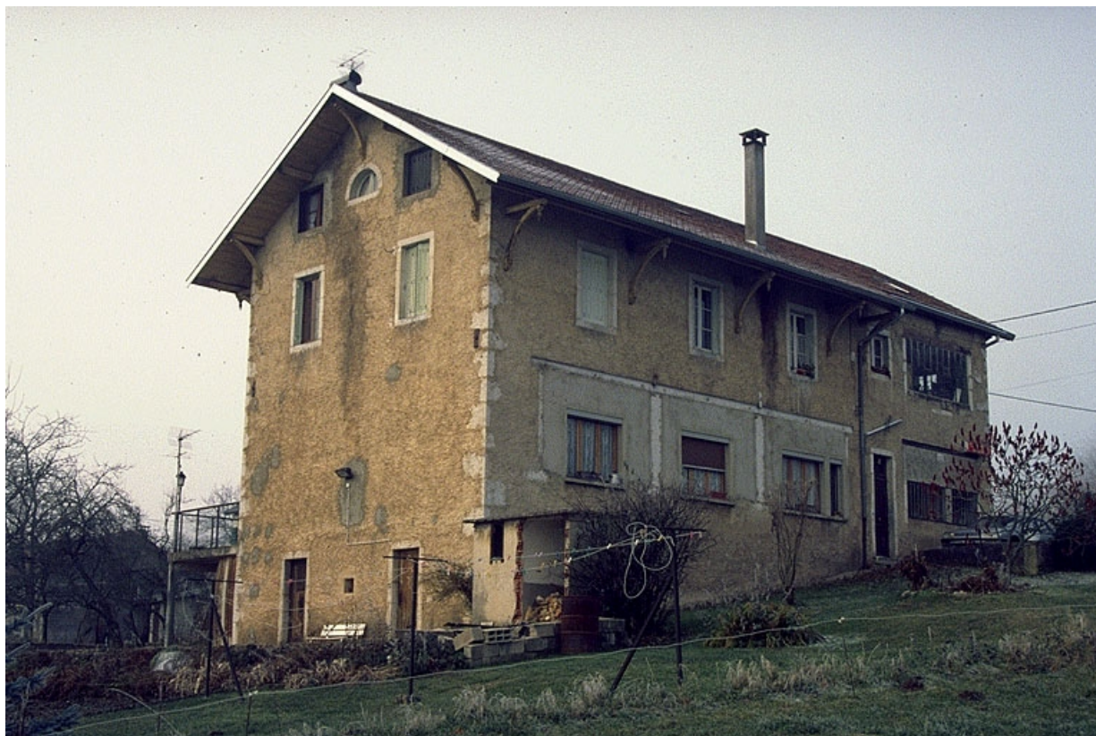
Façades postérieure et latérale gauche.
