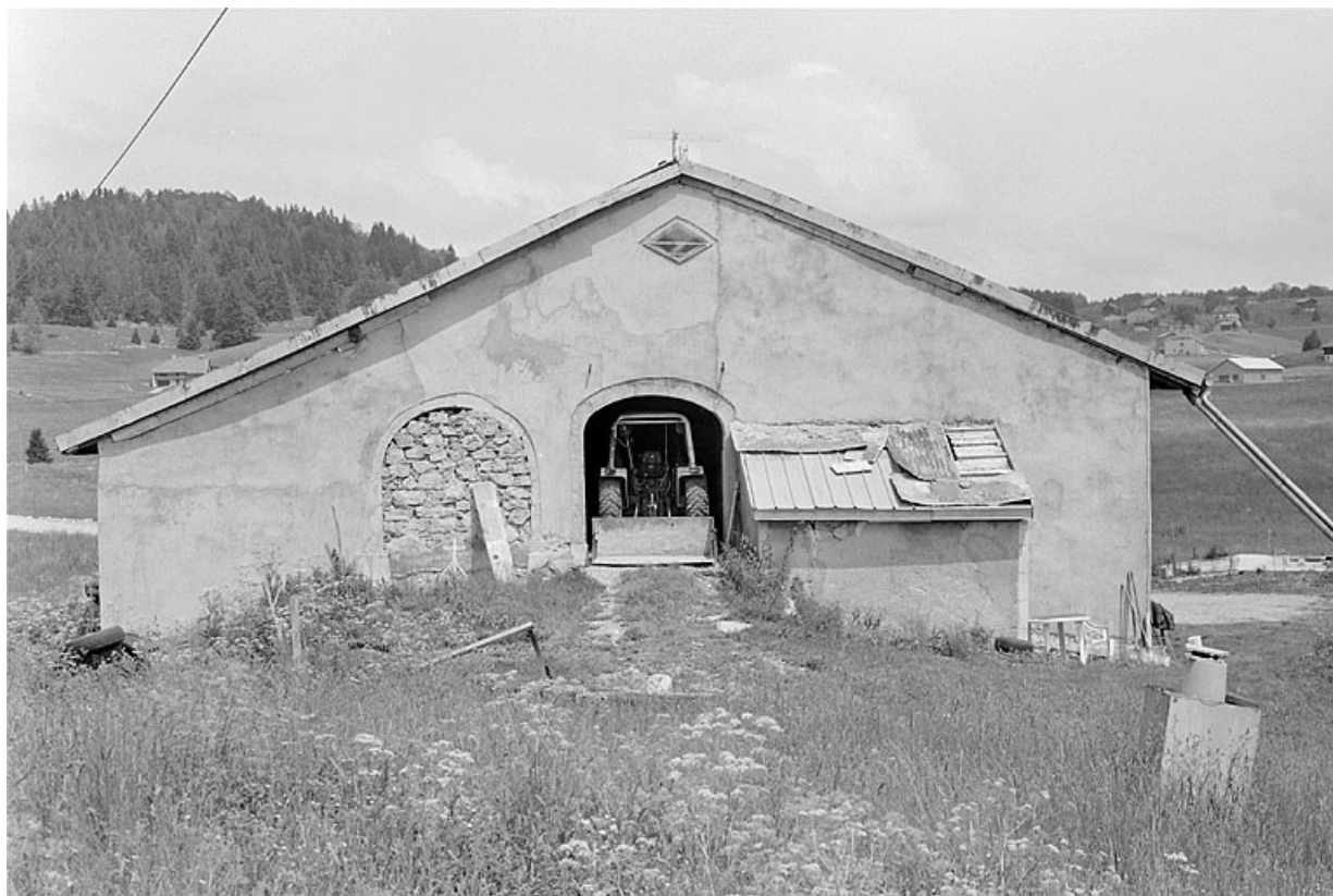
Ferme rehaussée et agrandie au hameau de Petite Joux.
