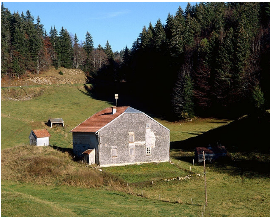
Vue générale depuis le sud-ouest.
