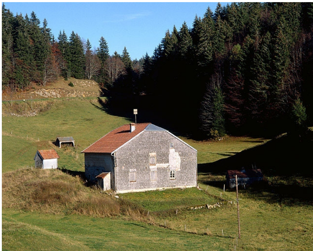
Vue générale depuis le sud-ouest.
