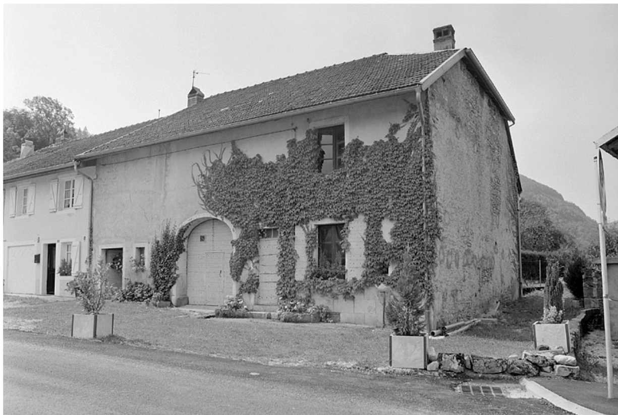
La façade antérieure et la face droite vues de trois quarts.
