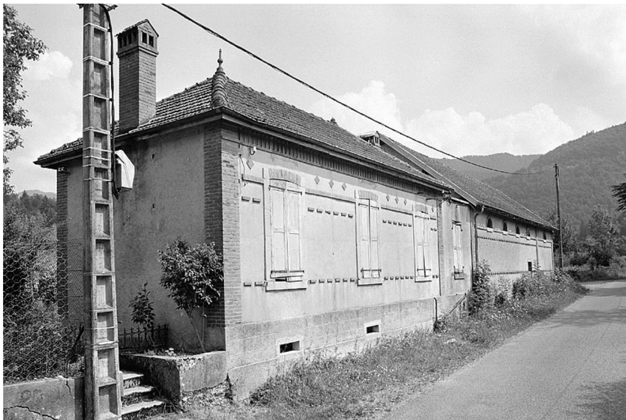
Vue de la façade postérieure du logis et des dépendances agricoles.
