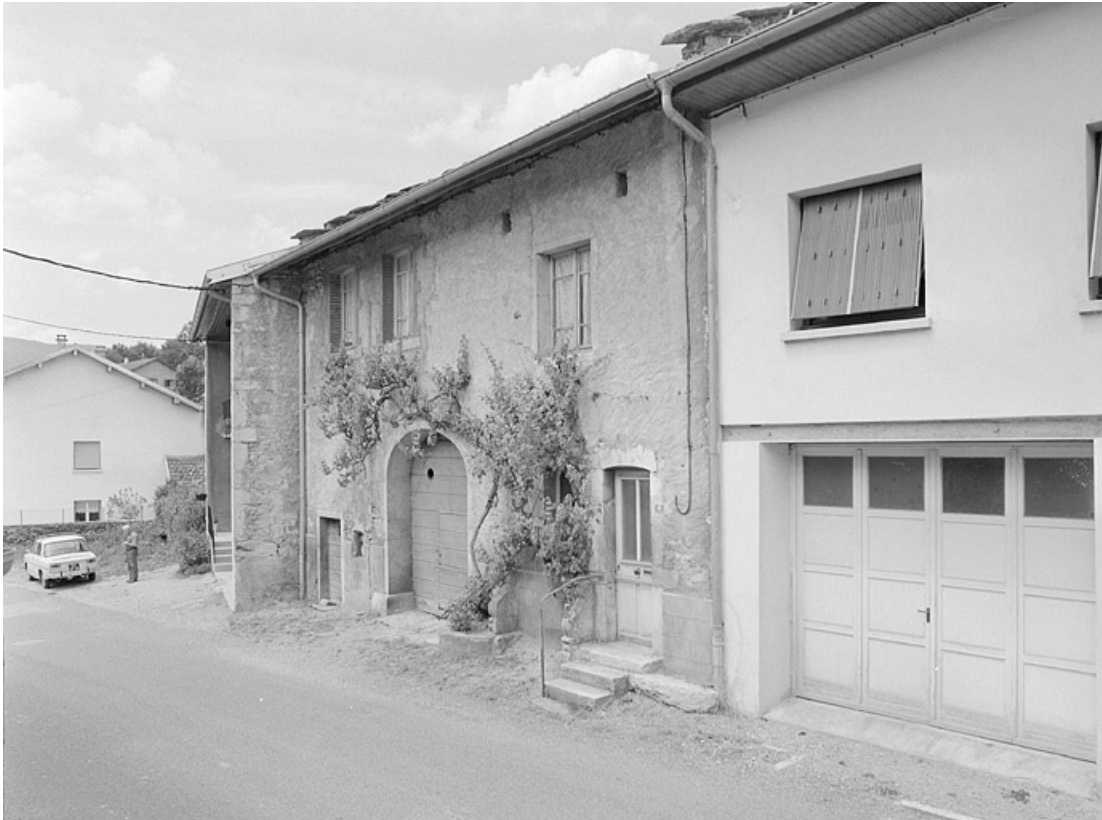
Façade sur rue. 39, Chassal
