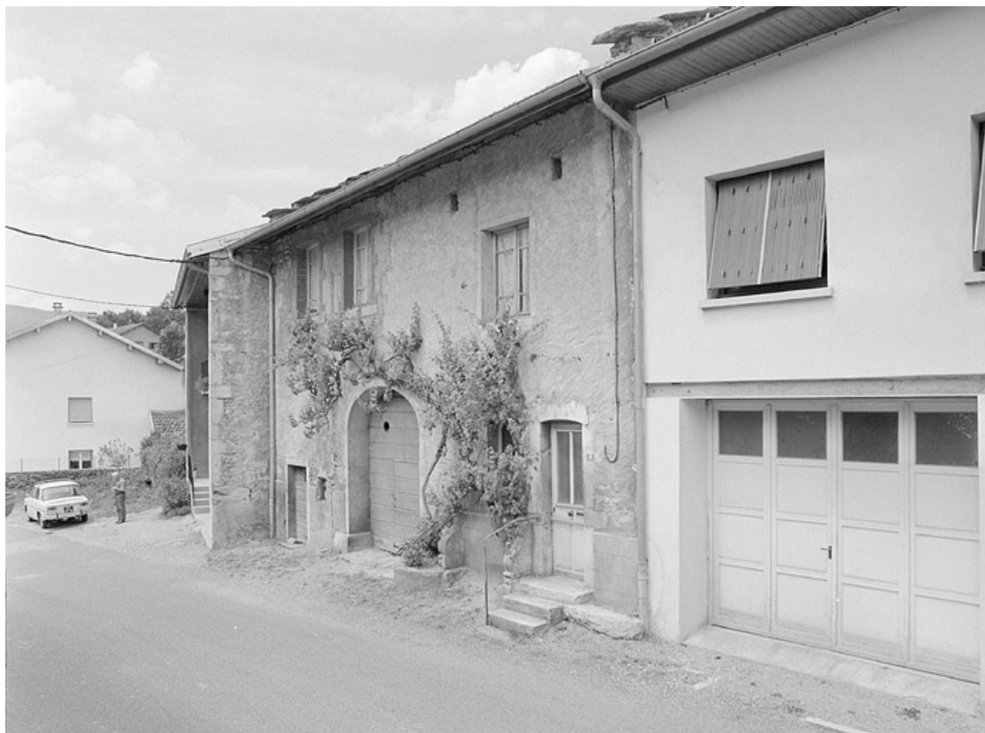
Façade sur rue. 39, Chassal
