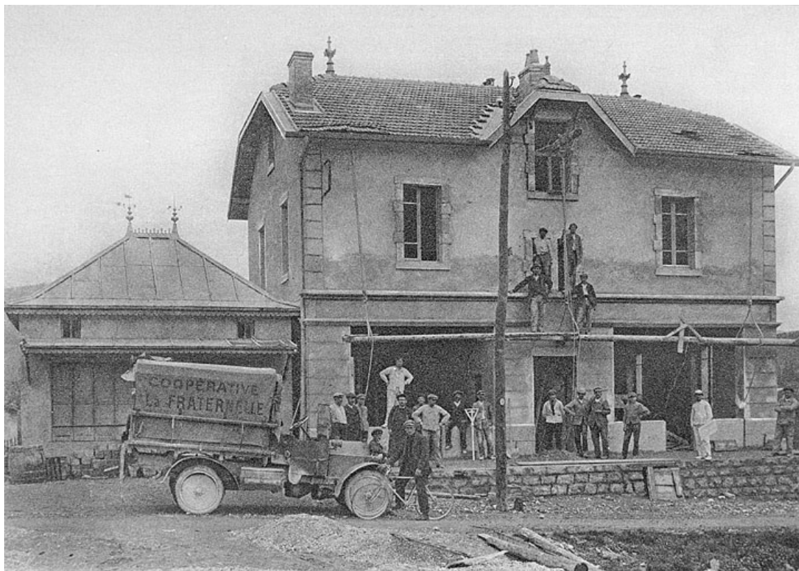
La Fraternelle, Société coopérative d'alimentation ; succursale de Chassal - Immeuble en construction. 39, Chassal
