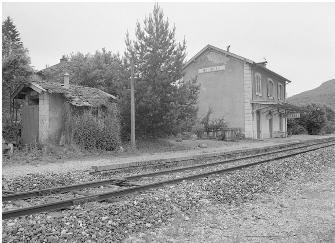
Vue d'ensemble depuis la voie, côté Andelot-en-Montagne (est).
