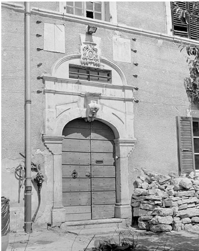
La porte d'accès de la façade antérieure.
