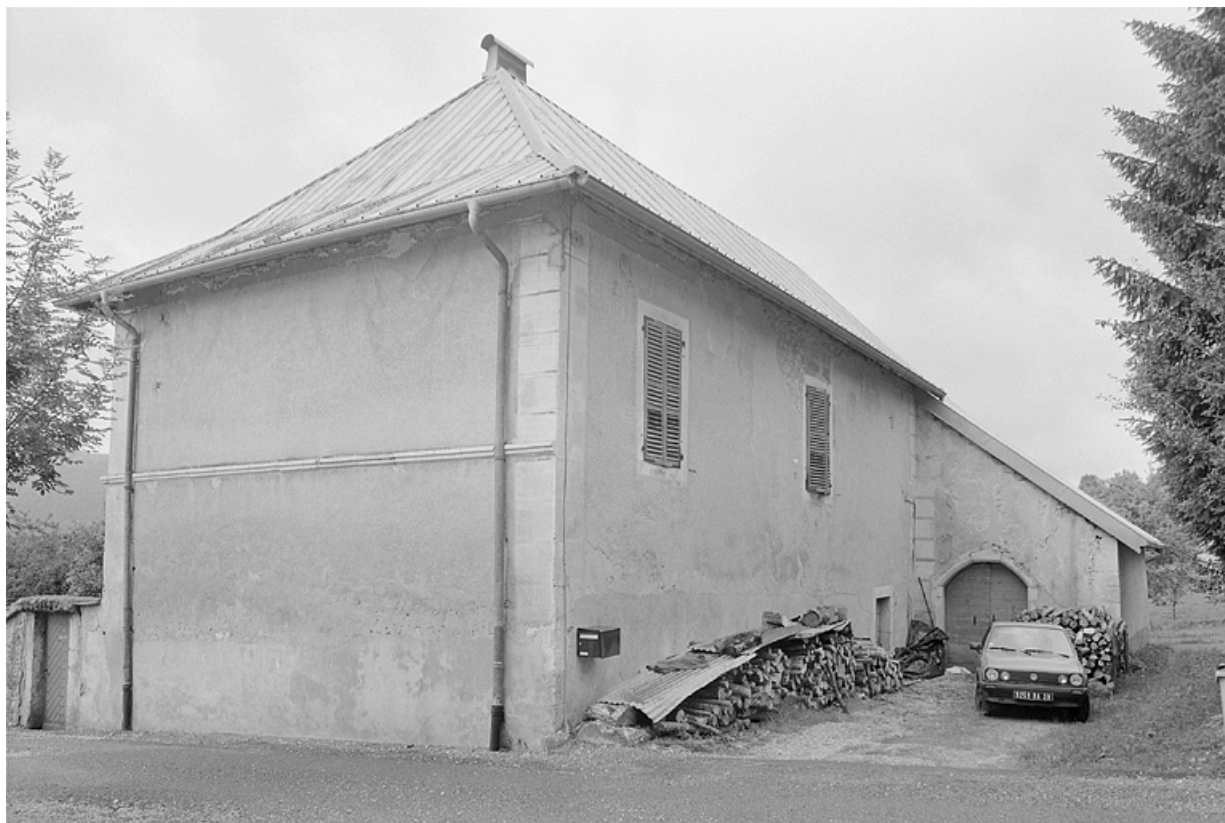
Façade postérieure et face droite.
