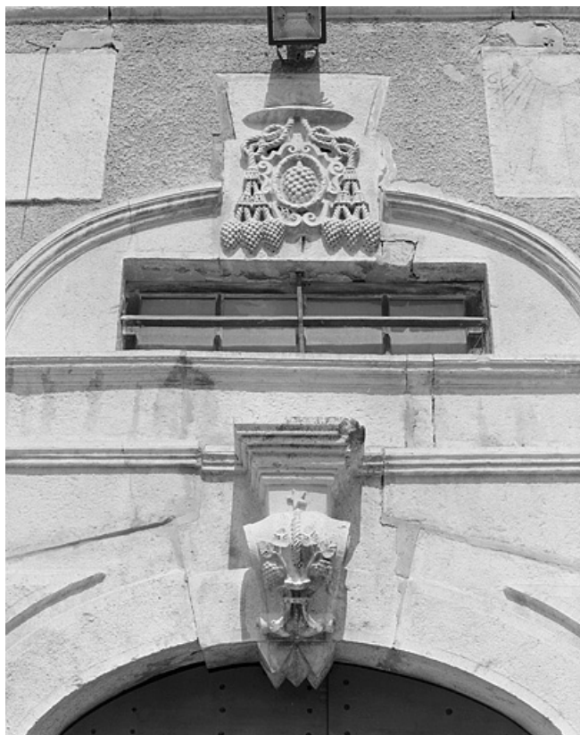
Détail du décor de la porte d'accès de la façade antérieure. 39, La Rixouse
