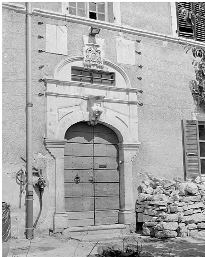
La porte d'accès de la façade antérieure.
