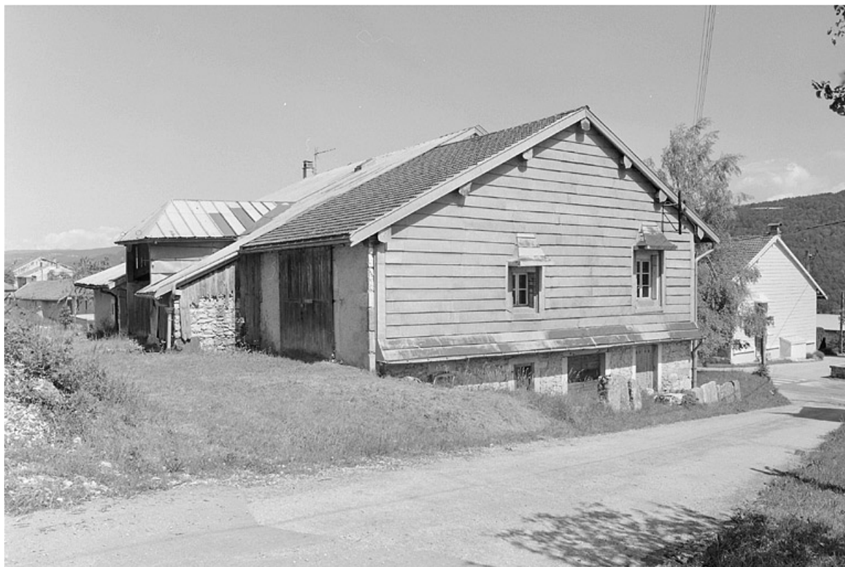
Façade postérieure et extension sur le côté gauche.
