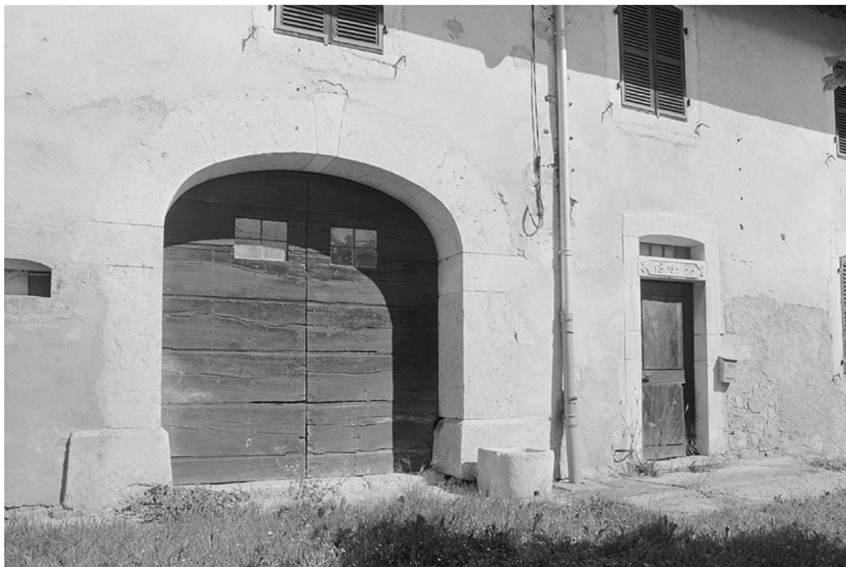
Porte de grange et accès au logis.
