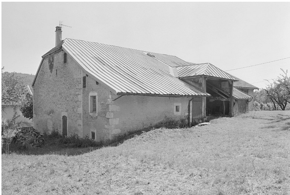
Façade postérieure et face droite.
