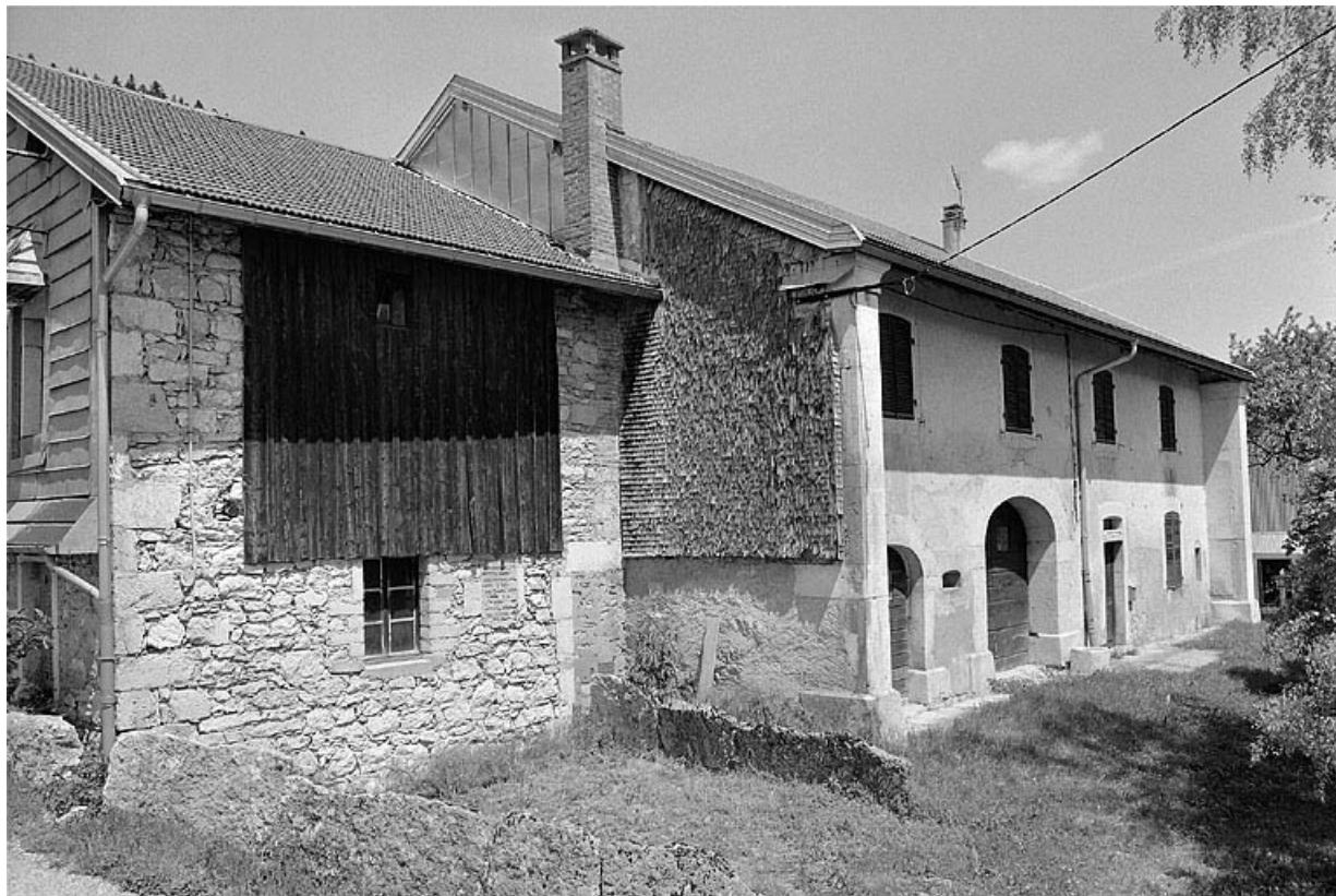
Façade antérieure de trois quarts et extension sur la face gauche. 39, Villard-sur-Bienne Vallée
