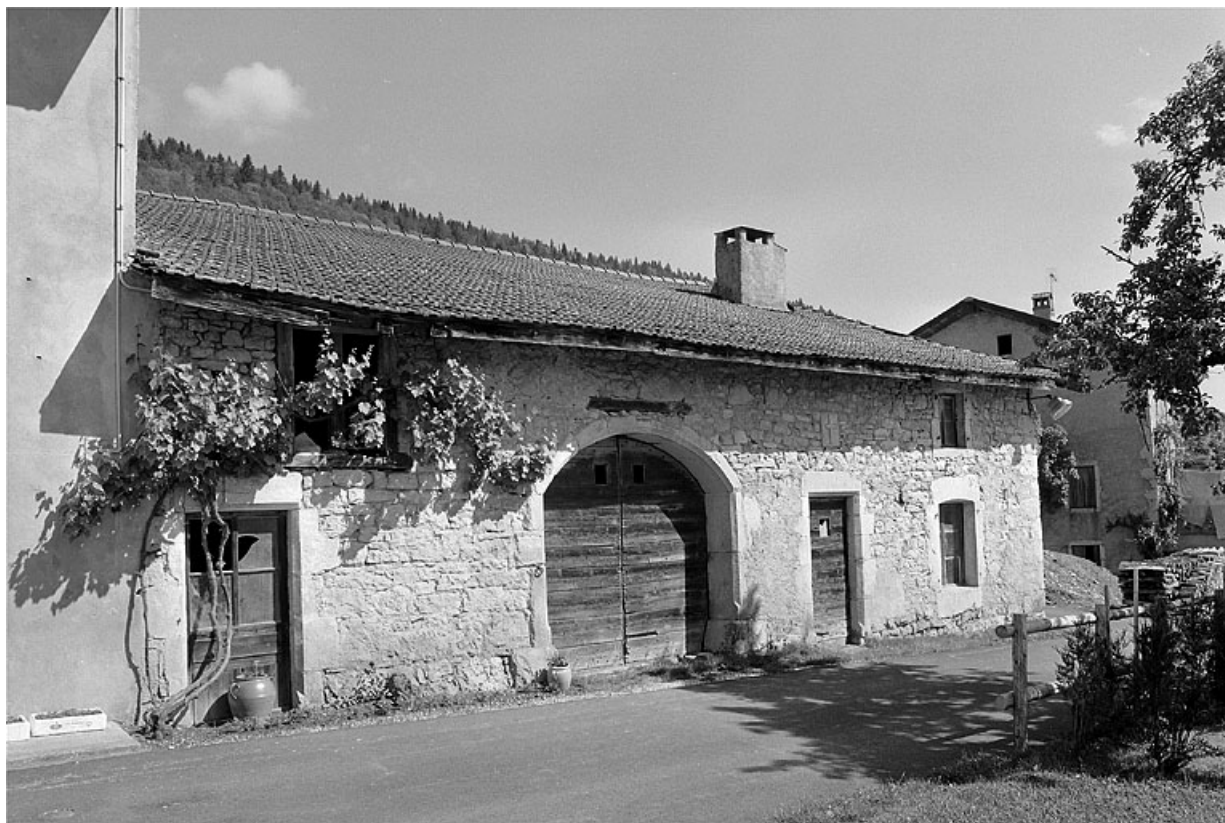
Ferme à trois travées : étable, grange, logis.
