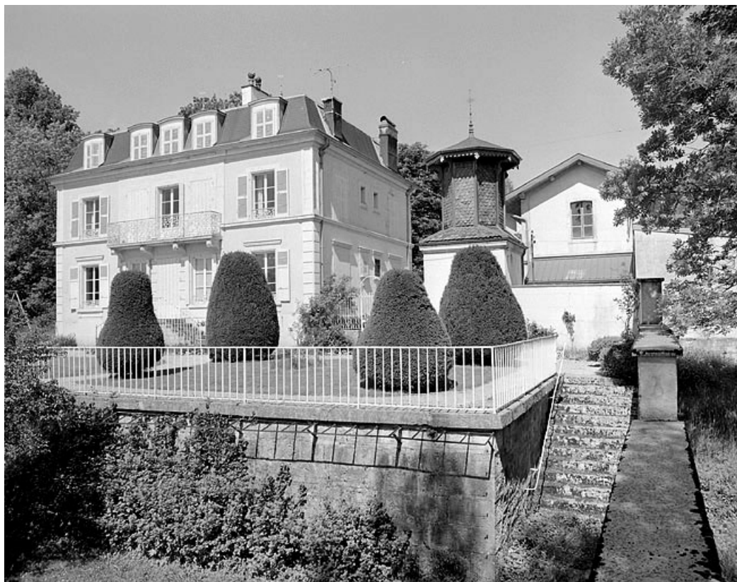
Façade sur jardin de la demeure, pigeonnier et face latérale de l'atelier.
