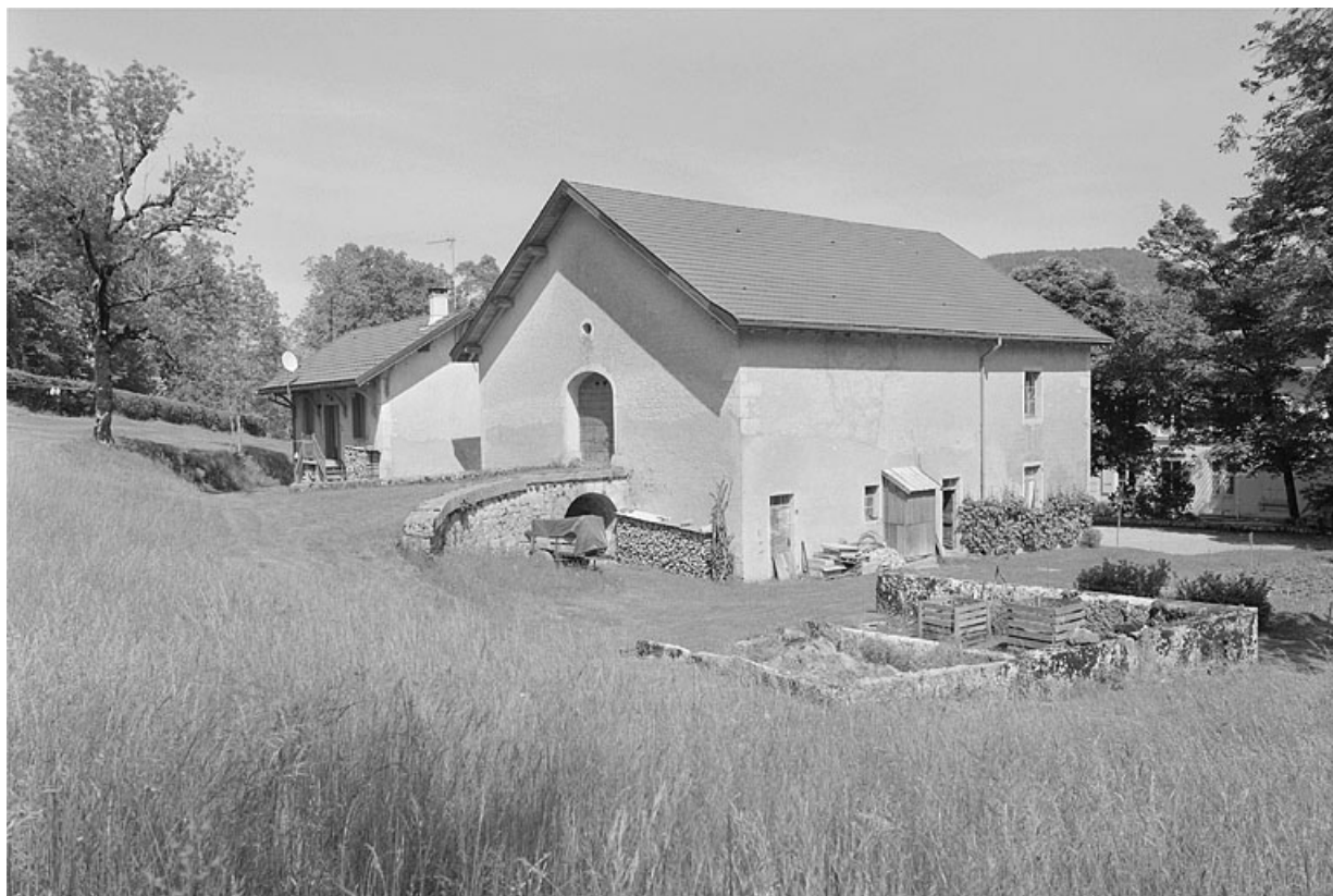
Face gauche et façade postérieure de la ferme.
