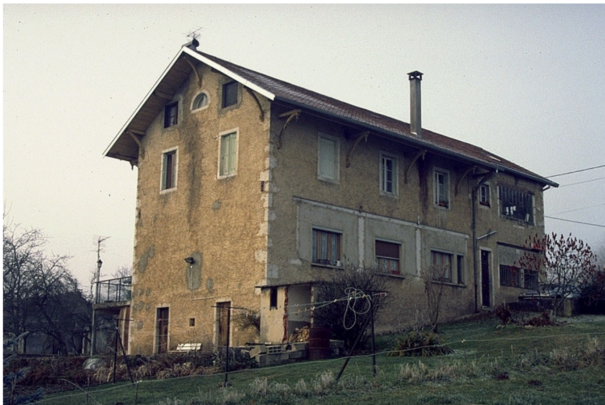
Façades postérieure et latérale gauche.
