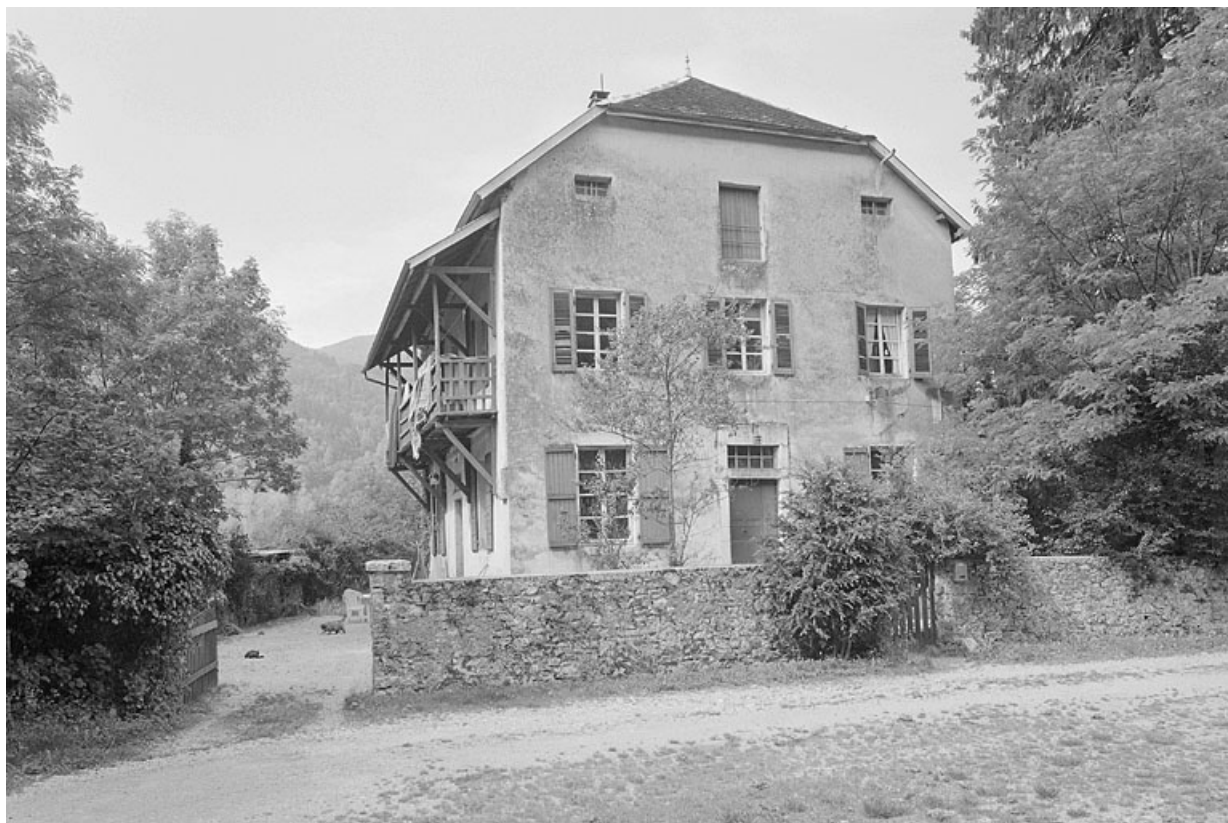
Vue générale de la façade antérieure. 39, Vaux-lès-Saint-Claude
