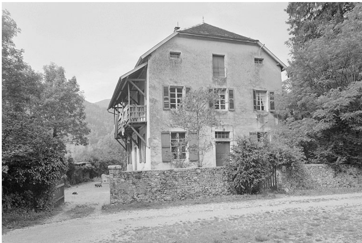
Vue générale de la façade antérieure. 39, Vaux-lès-Saint-Claude
