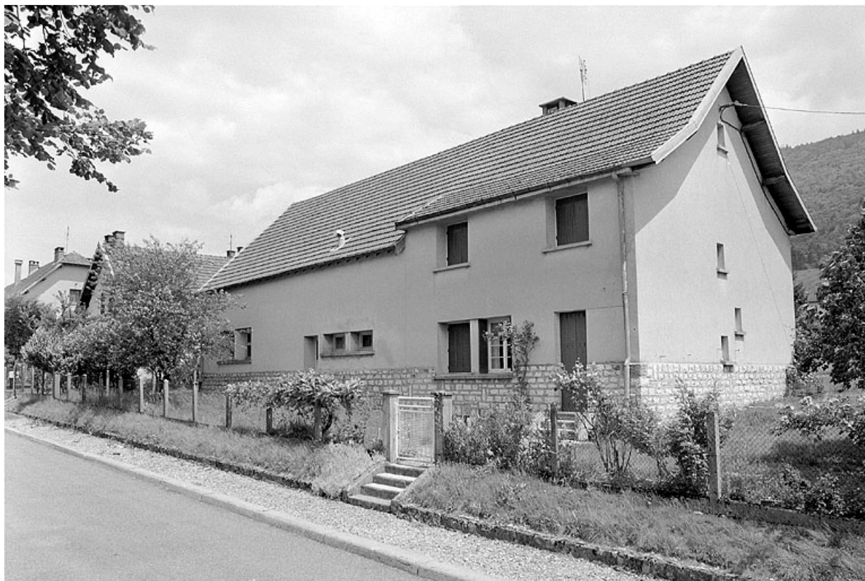
Vue de trois quarts de la façade postérieure et de la face gauche.
