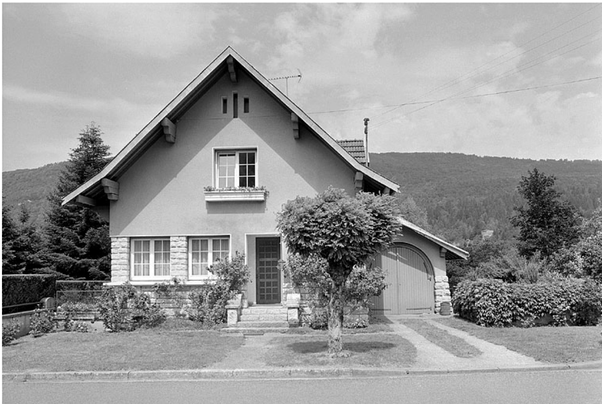
Maison reconstruite après guerre.
