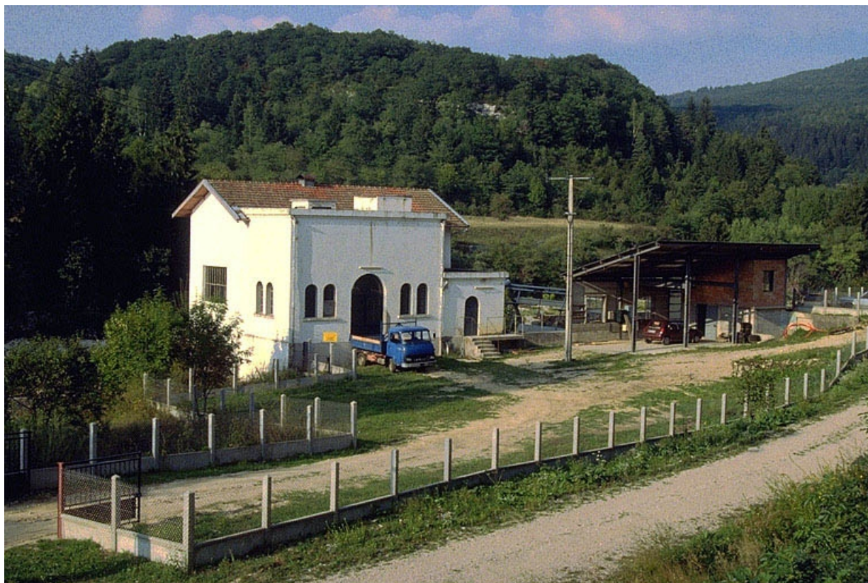
Centrale et remise d'automobile.
