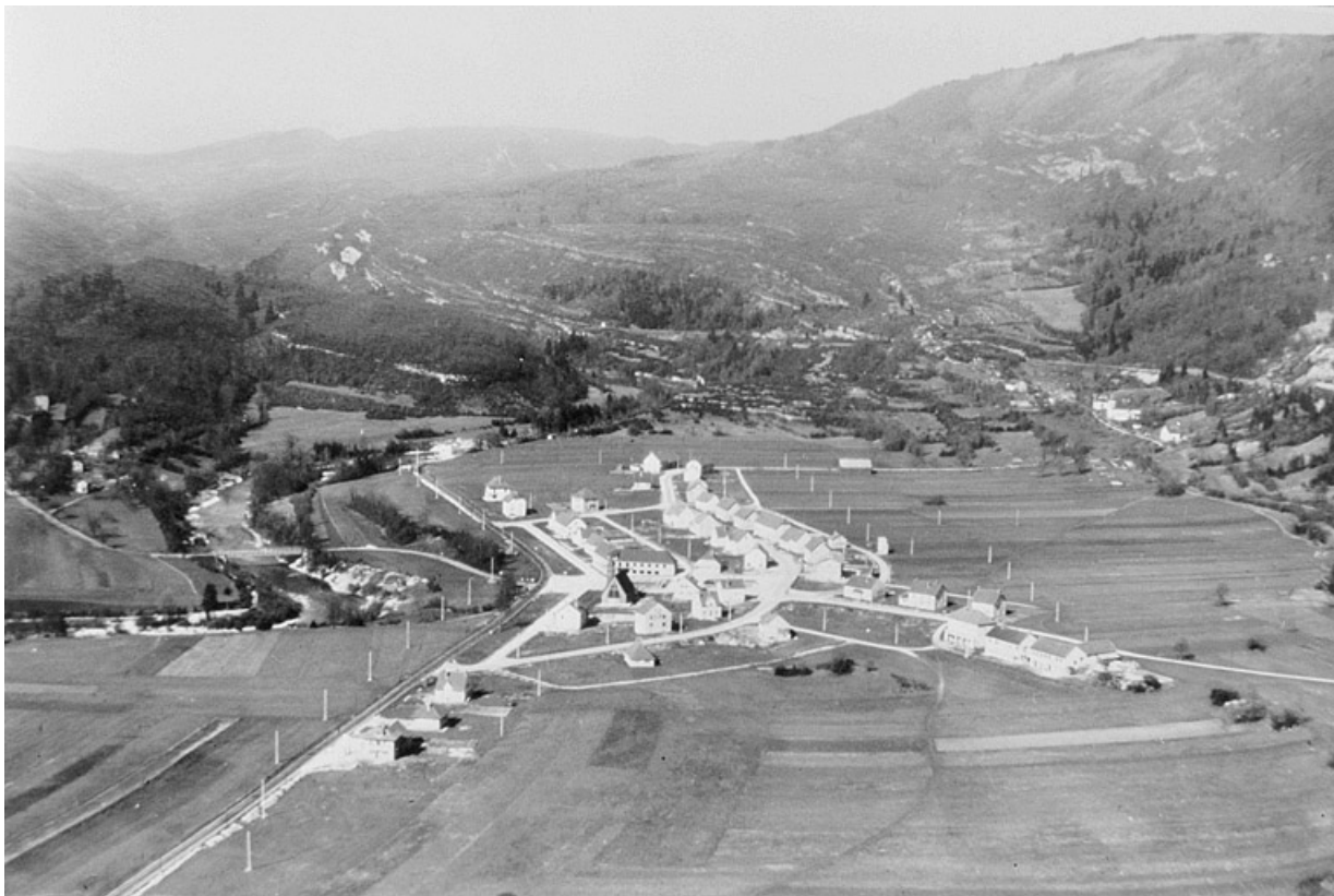
Vue aérienne de Lavancia-Epercy lors de la construction du nouveau village.
