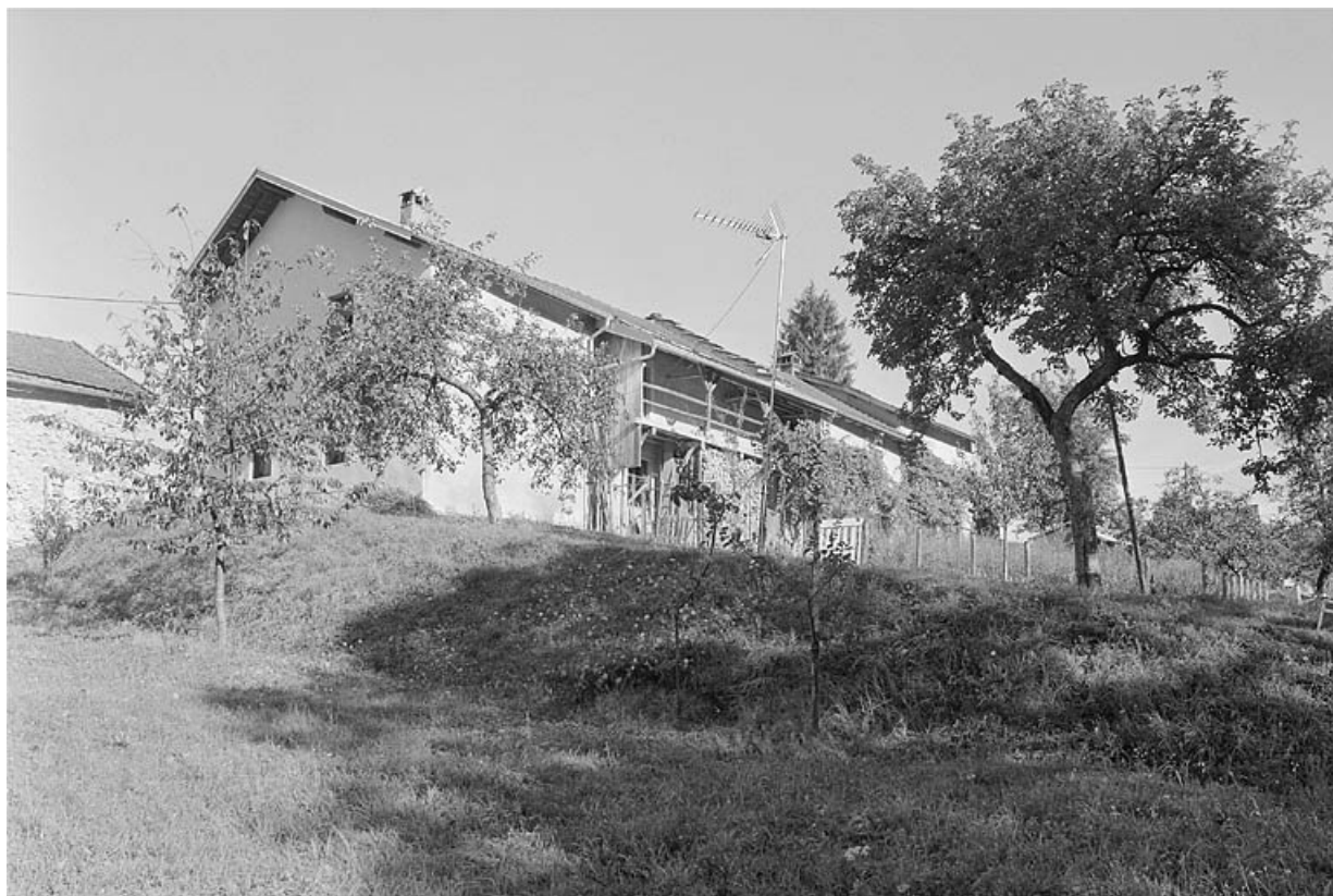
Vue d'ensemble de la façade postérieure.
