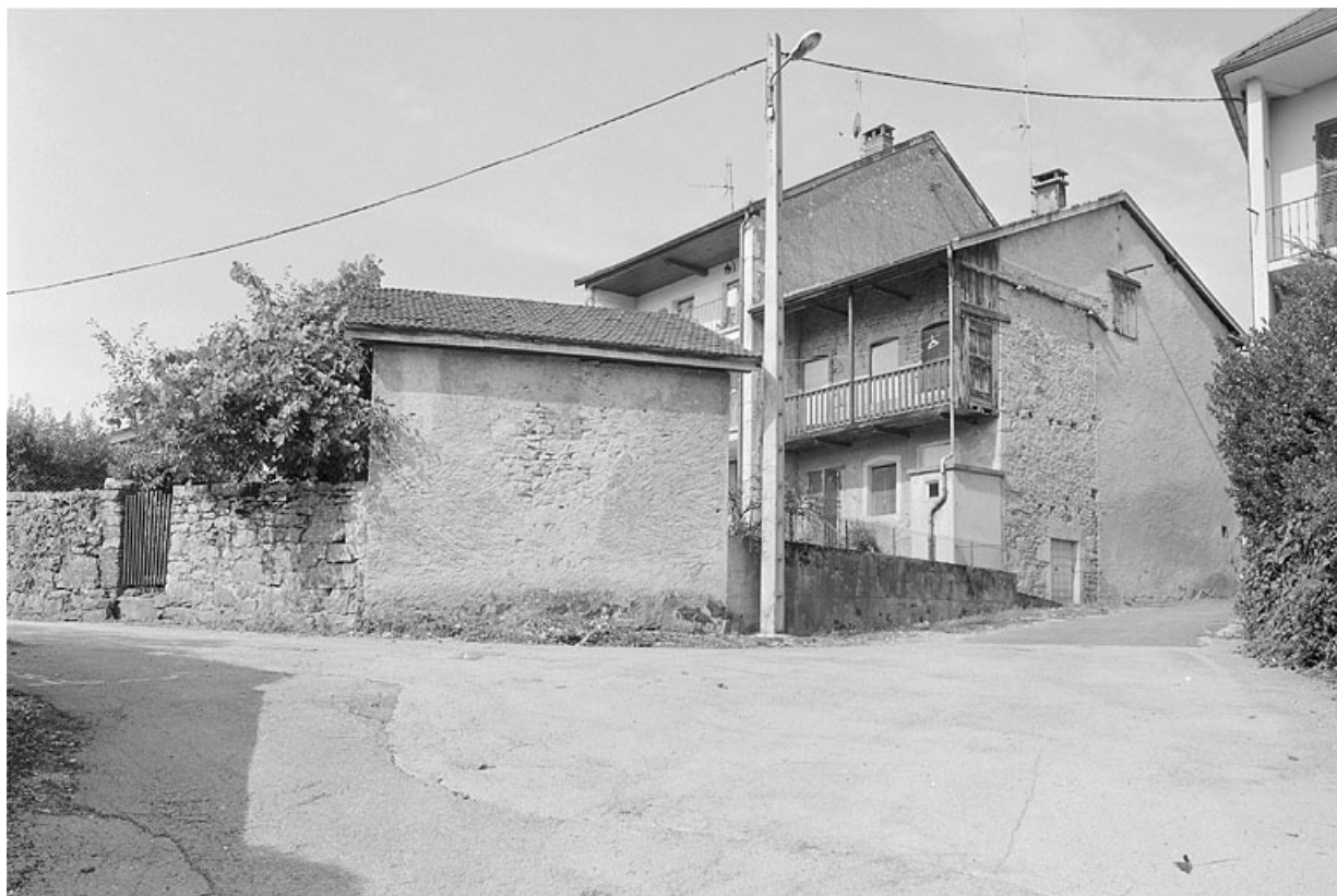
Angle est de la maison et façade postérieure de l'atelier.
