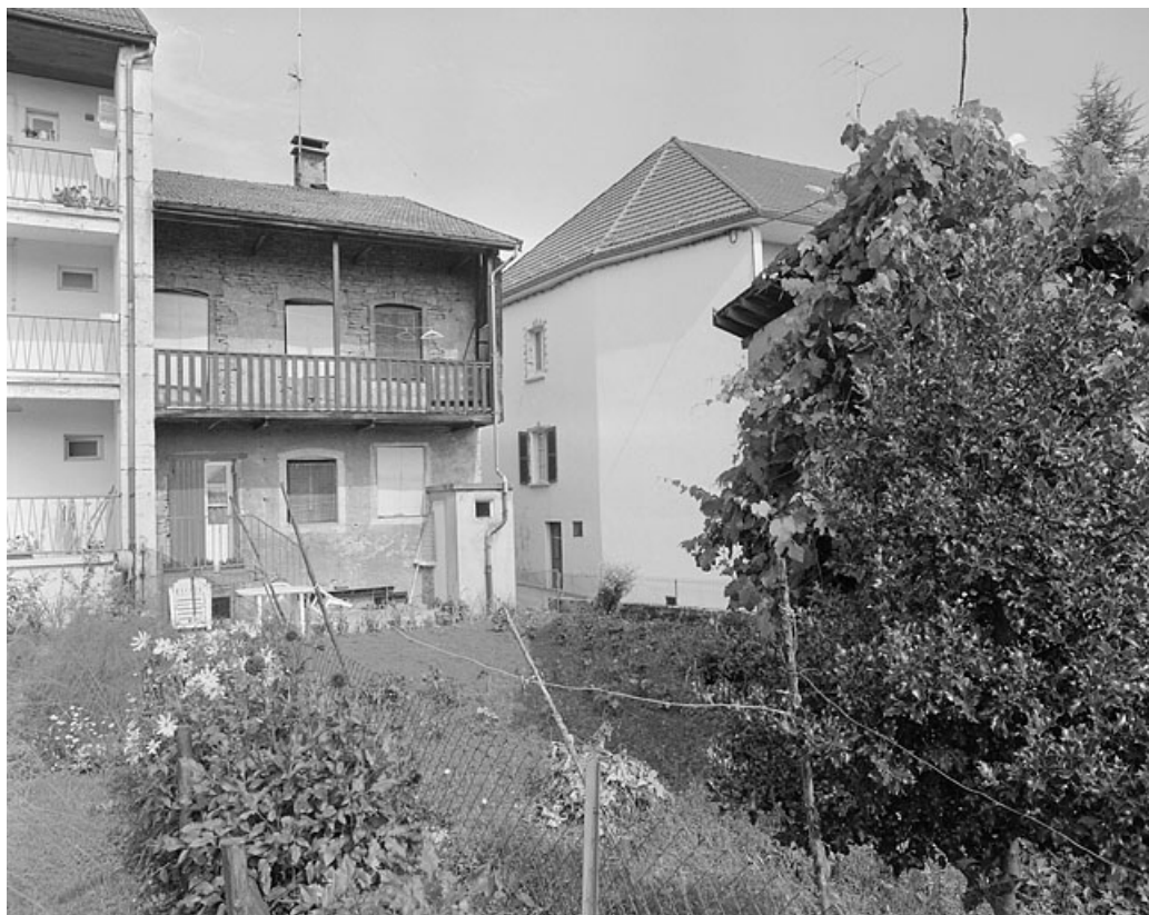
Façade postérieure avec balcon en galerie.
