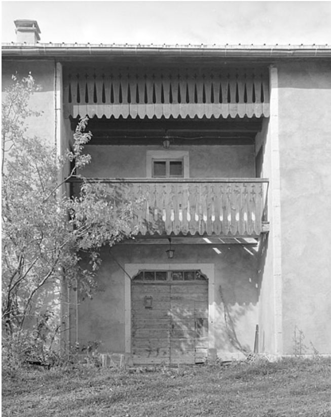
Galerie centrale sur la façade antérieure.
