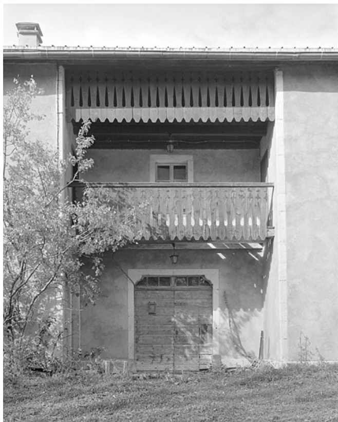
Galerie centrale sur la façade antérieure.
