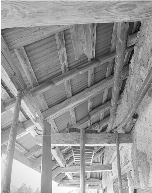
Détail de la charpente de l'avant-toit.
