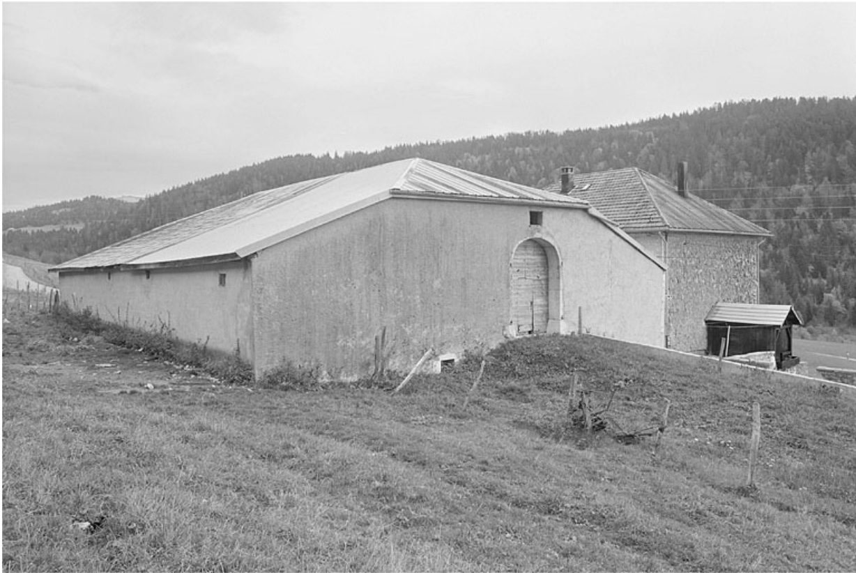
Face sud-ouest et façade postérieure.
