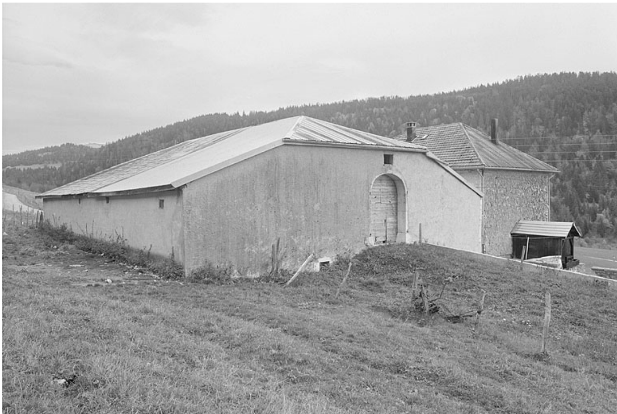
Face sud-ouest et façade postérieure.
