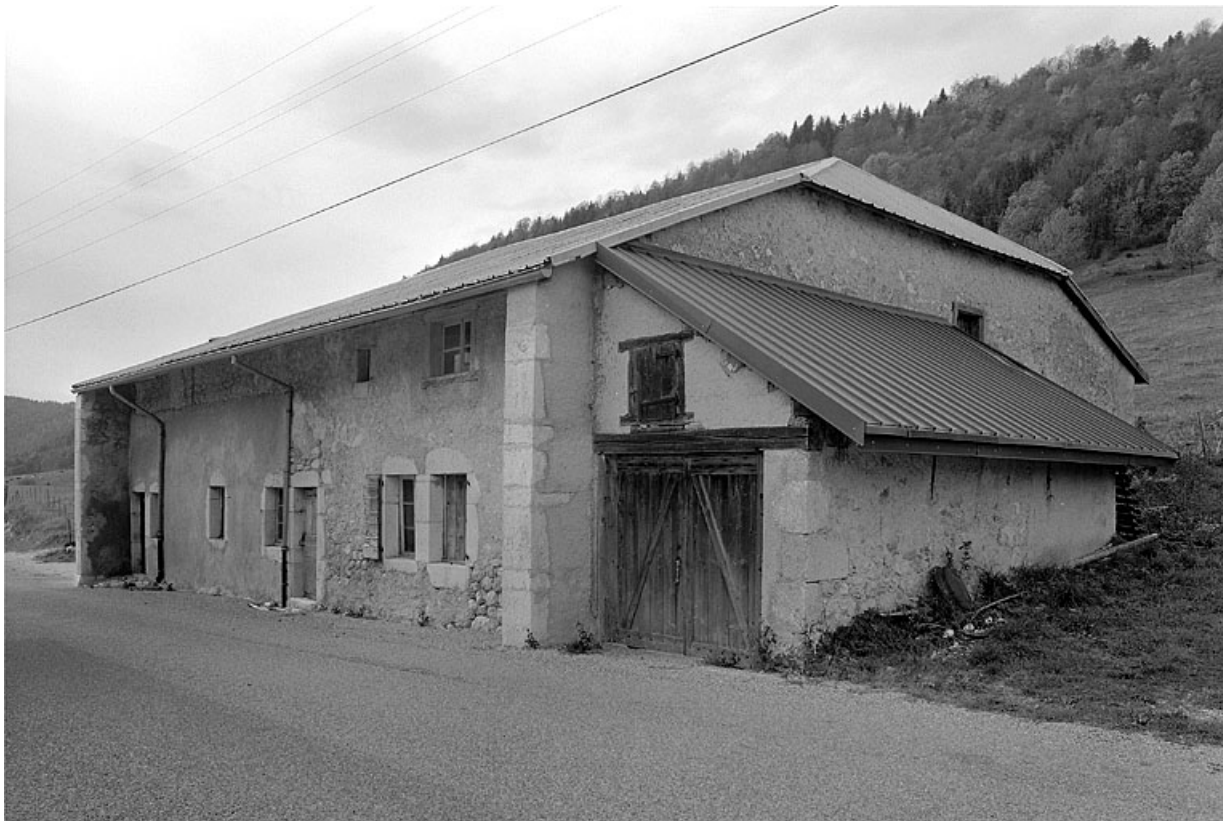
Façade antérieure et face nord-est.
