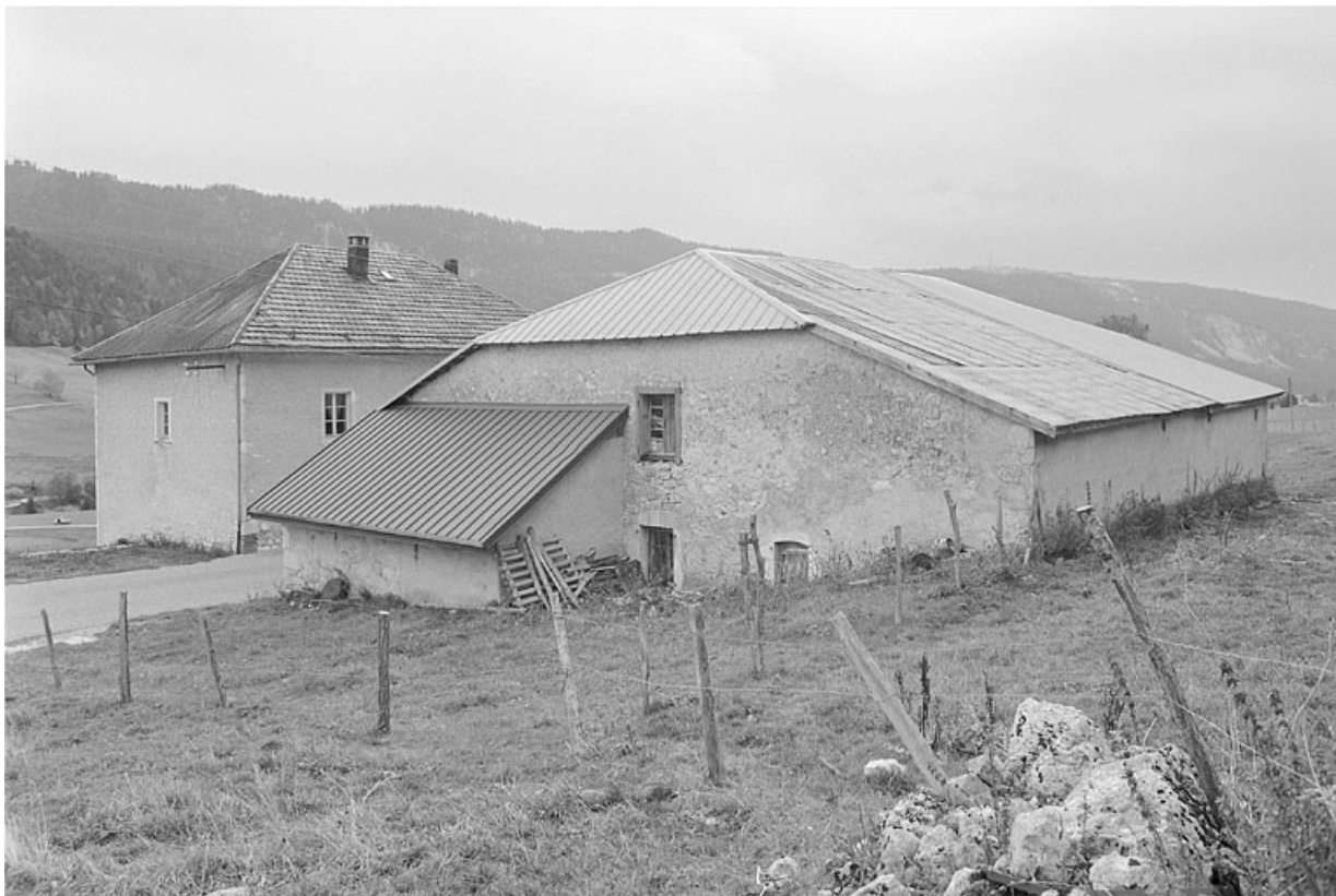
Façade postérieure et face nord-est.
