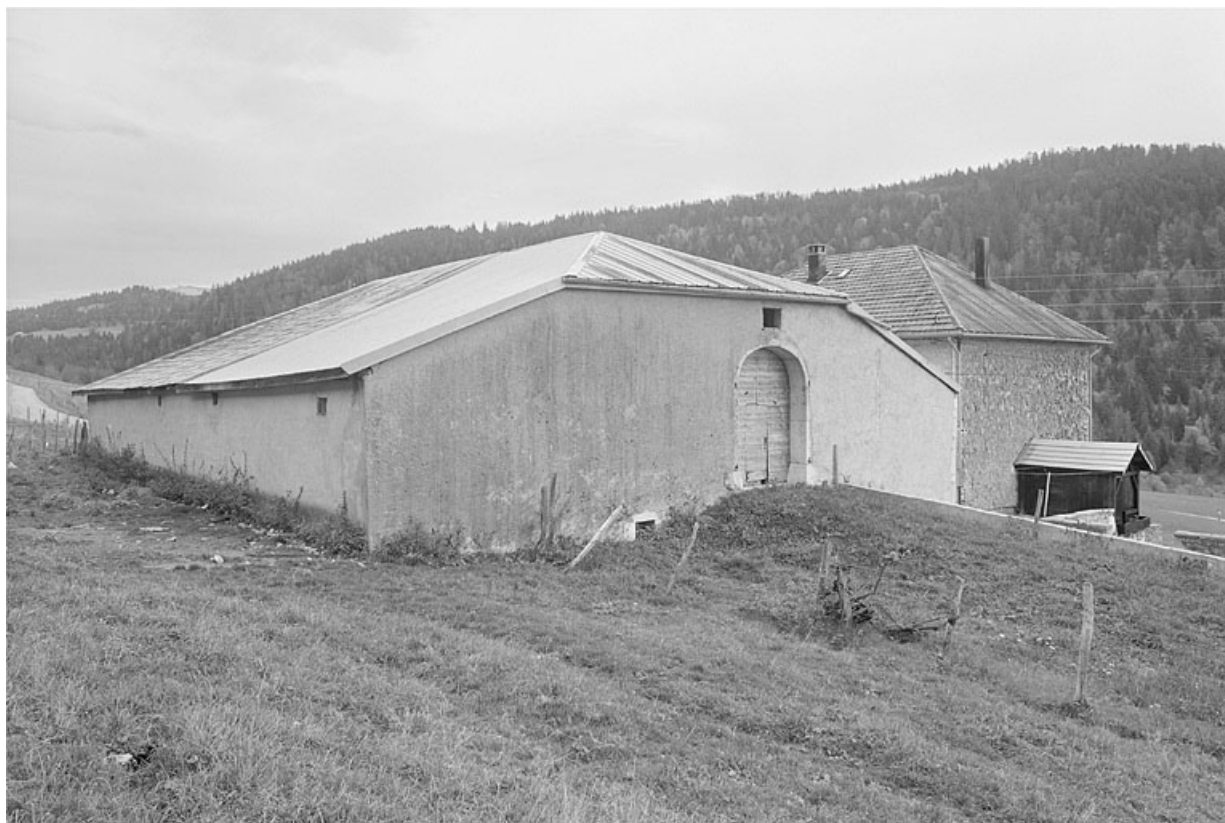
Face sud-ouest et façade postérieure.
