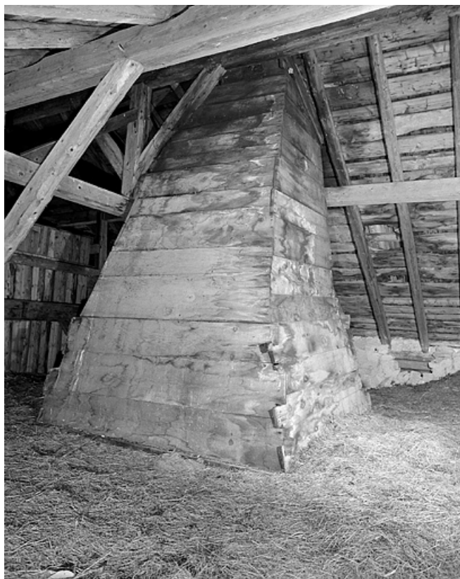
La cheminée en bois dans les combles.
