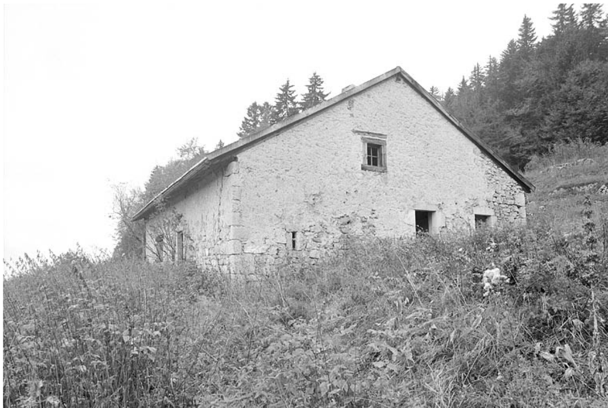
Face droite et façade antérieure.
