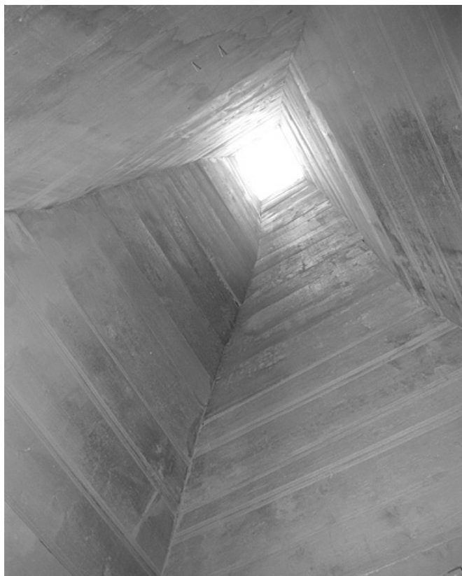
L'intérieur du conduit de la cheminée en bois.
