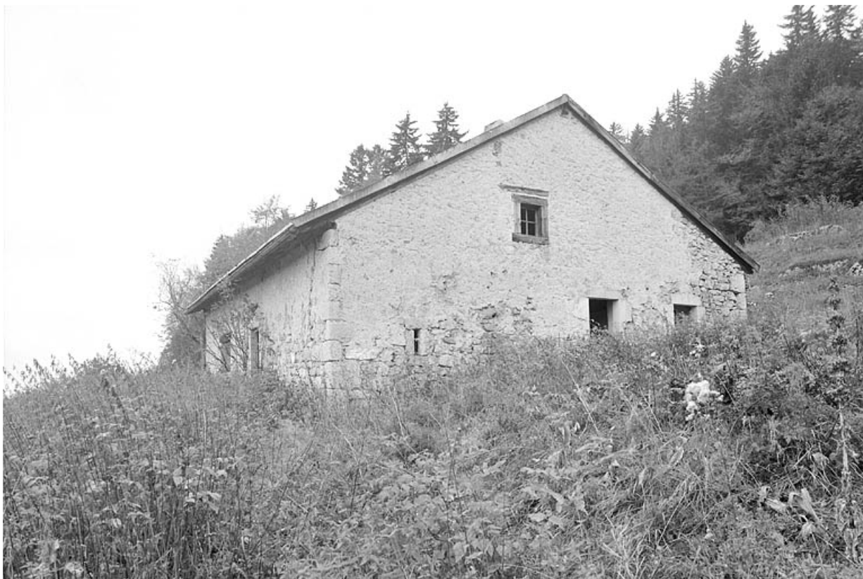
Face droite et façade antérieure.
