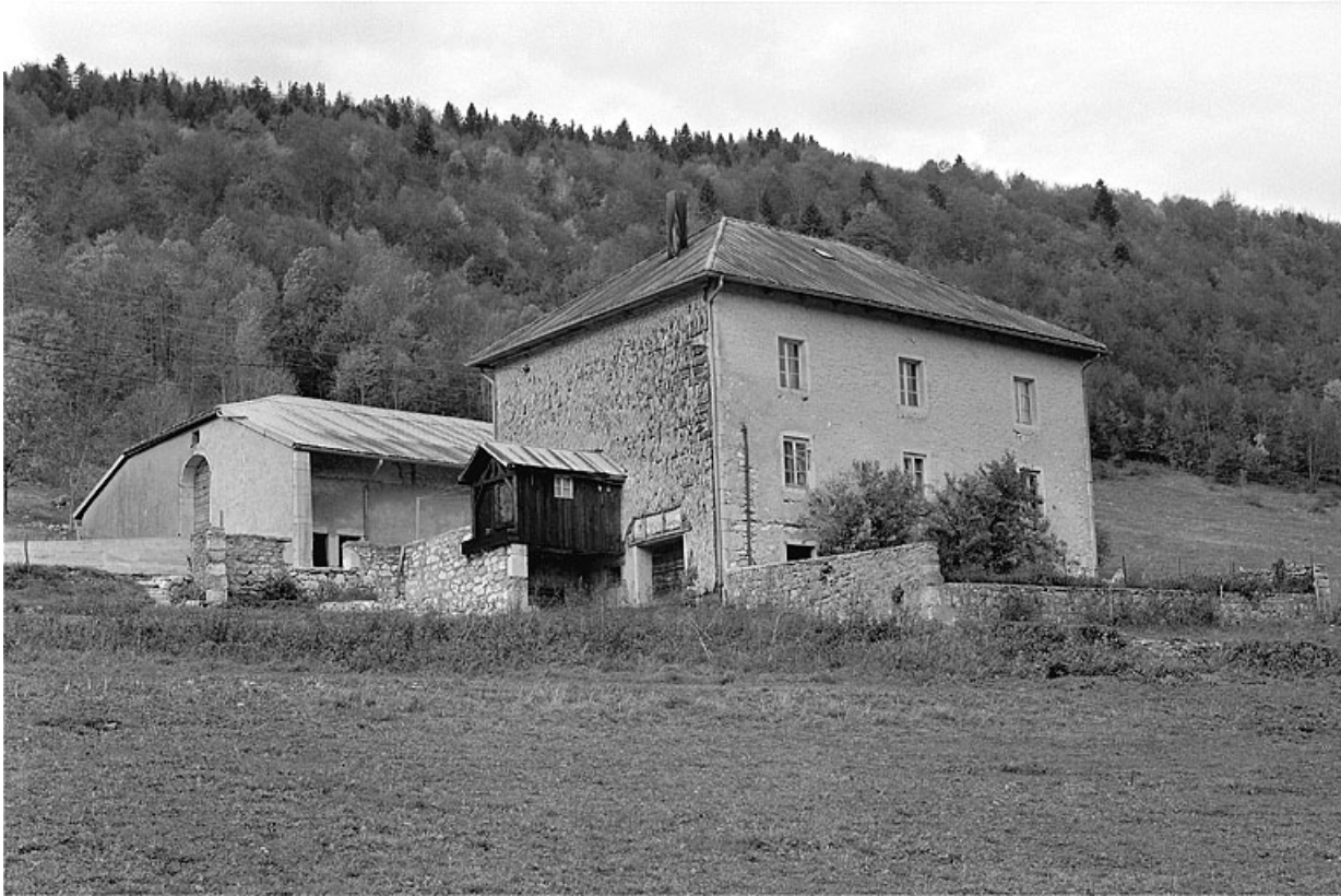
Face sud-ouest et façade postérieure.
