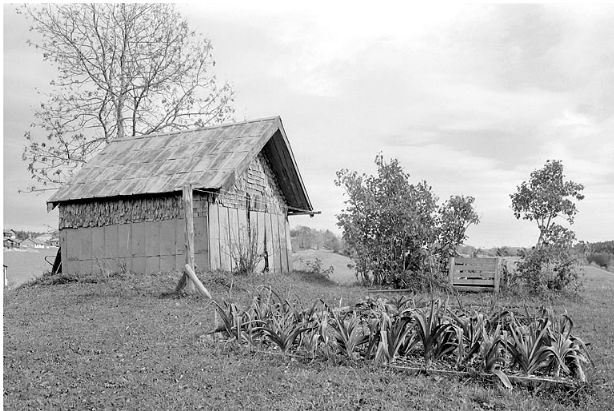
Le grenier fort aux côtés de la ferme.
