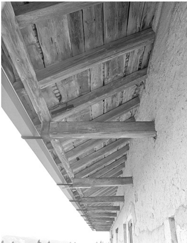
Détail de la charpente de l'avant toit.
