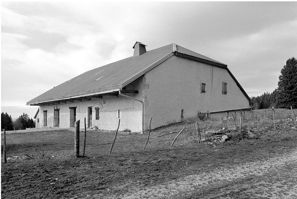
Façade antérieure et face nord-est.
