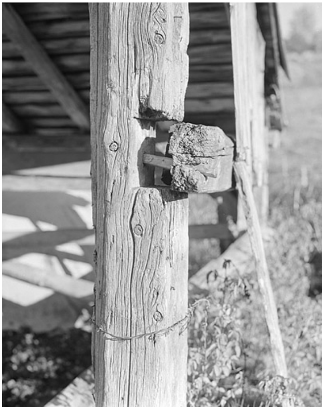
Assemblage à mi-bois poteaux-panne par une cheville.
