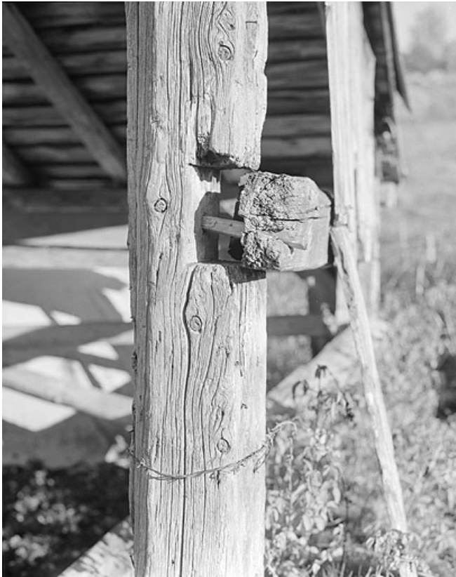
Assemblage à mi-bois poteaux-panne par une cheville.
