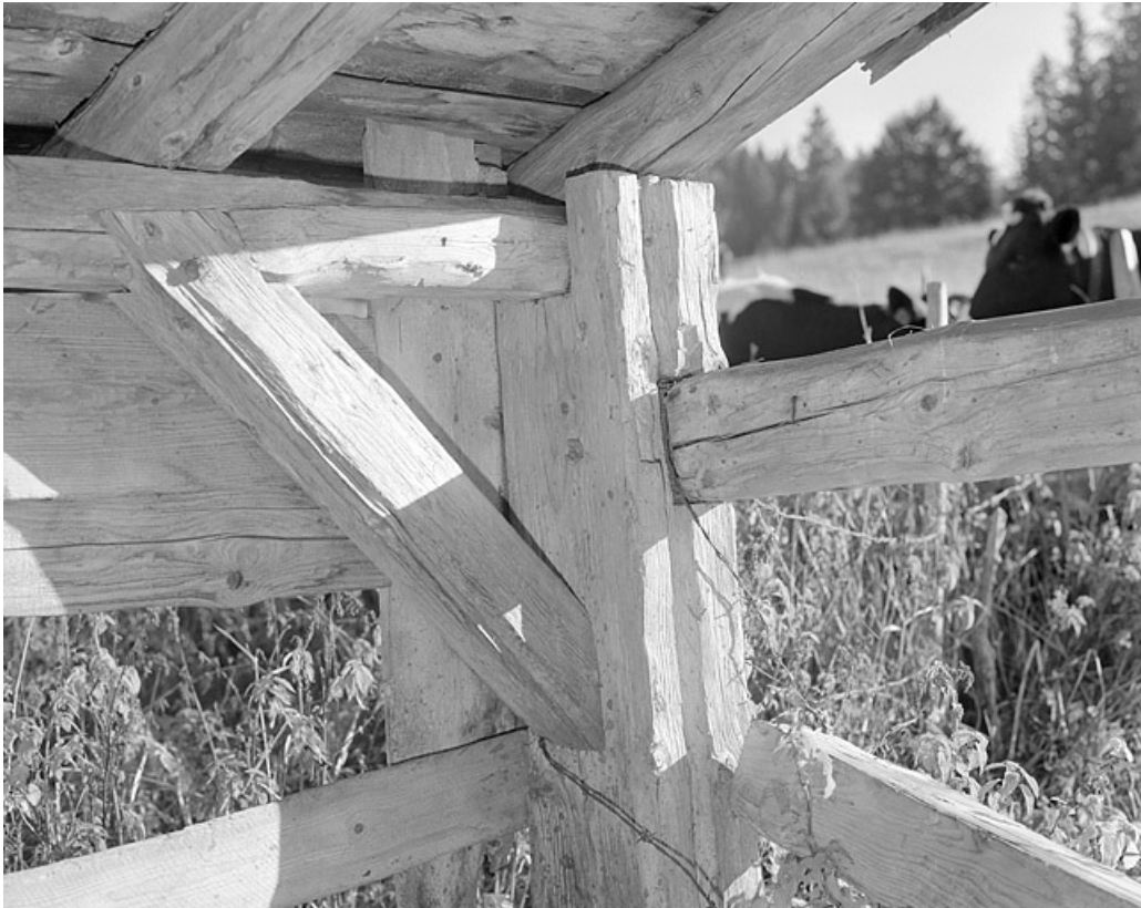
Assemblage de la charpente de l'abreuvoir.
