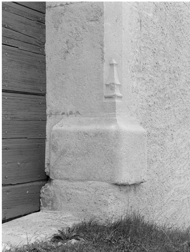
Détail d'un piédroit de la porte de la grange haute.
