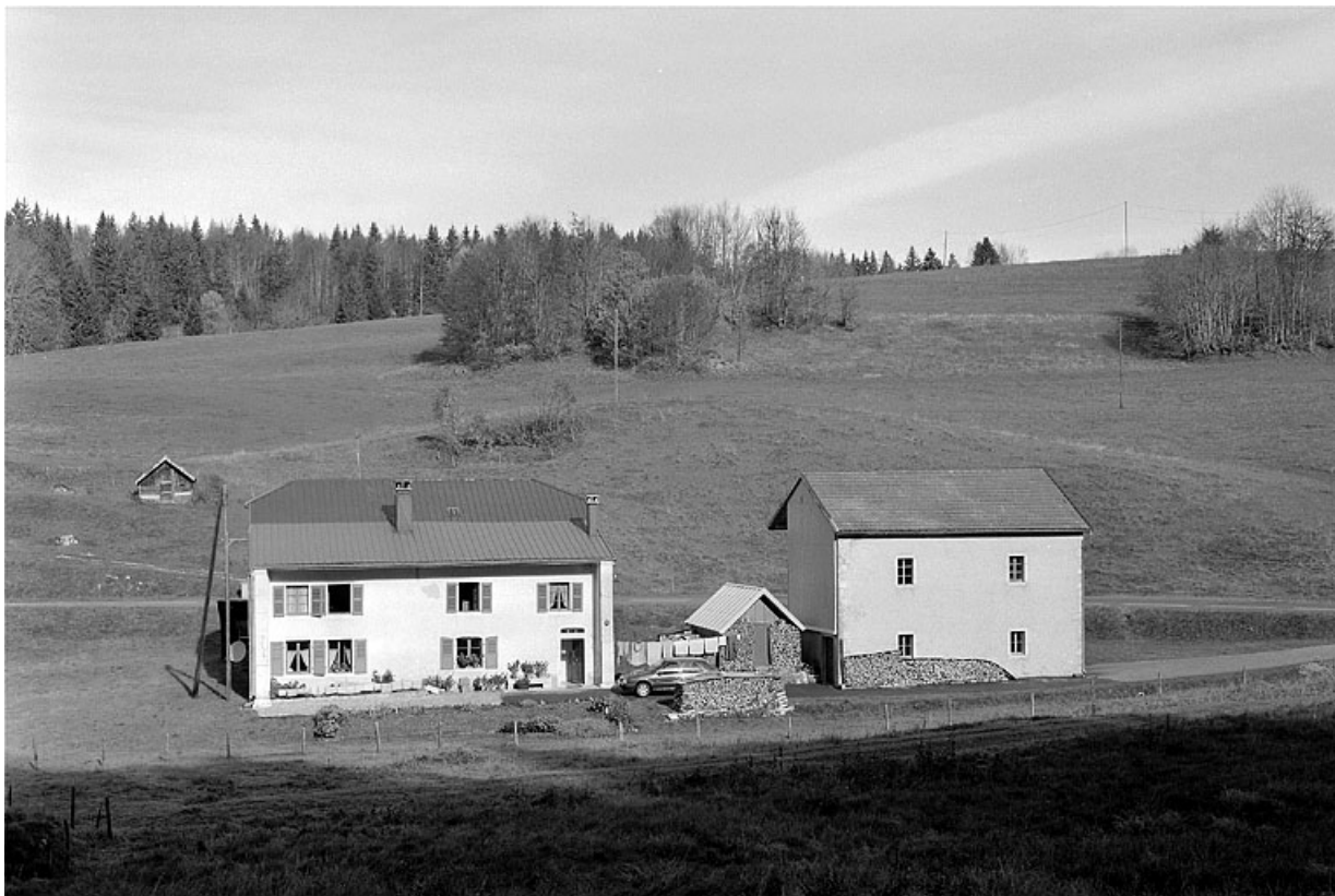
Vue d'ensemble de la ferme, du grenier fort et de la remise.
