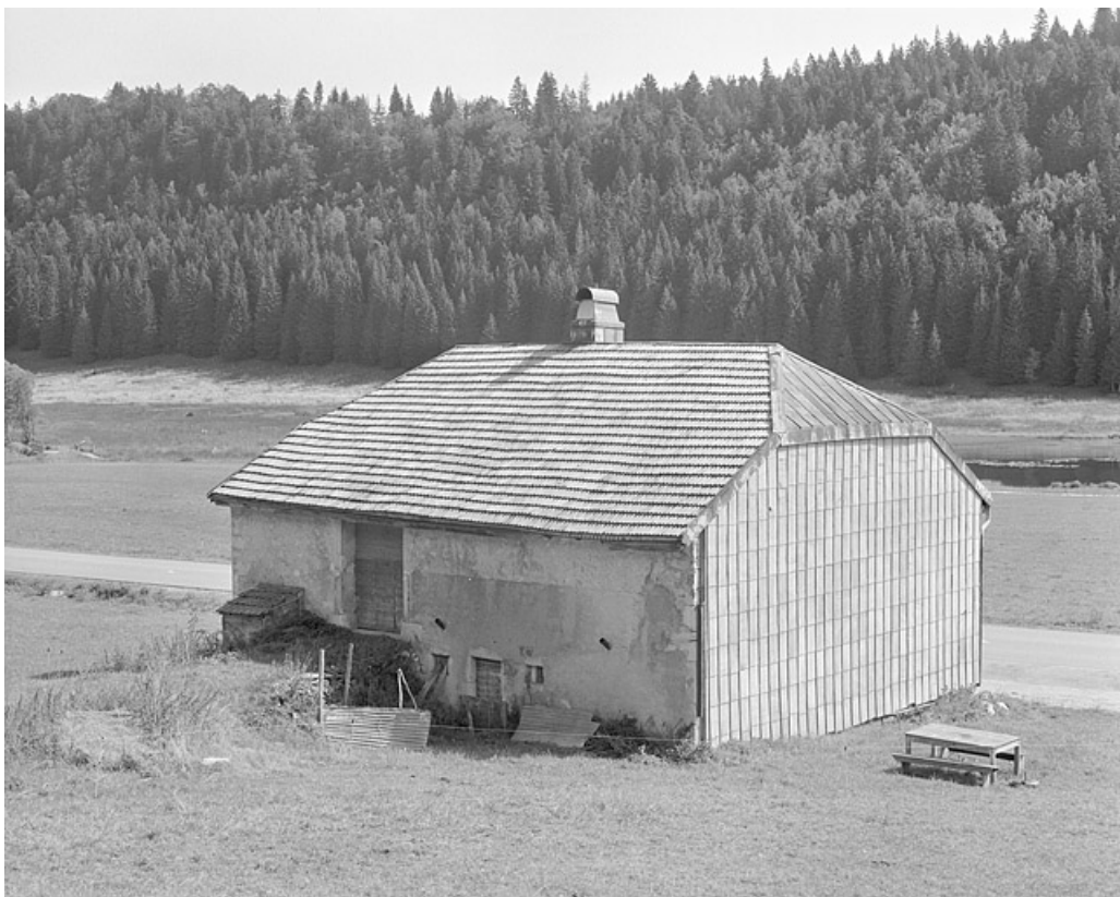
Face sud-ouest et façade postérieure.
