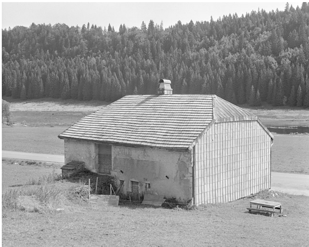
Face sud-ouest et façade postérieure.
