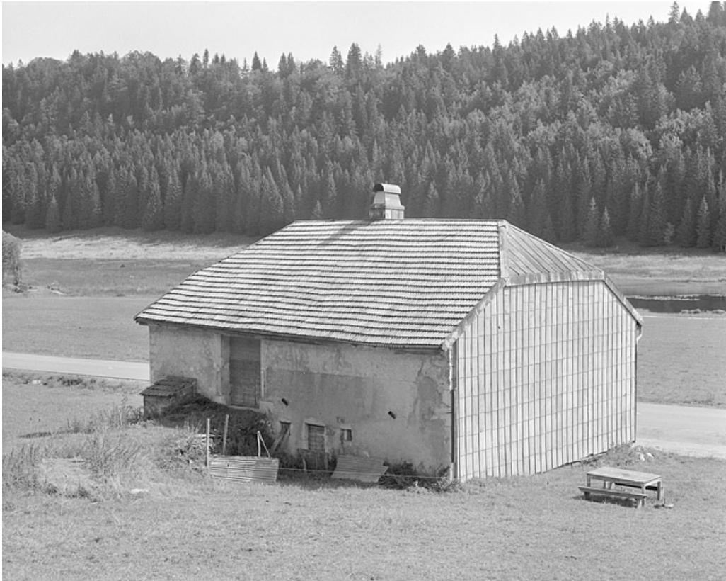
Face sud-ouest et façade postérieure.
