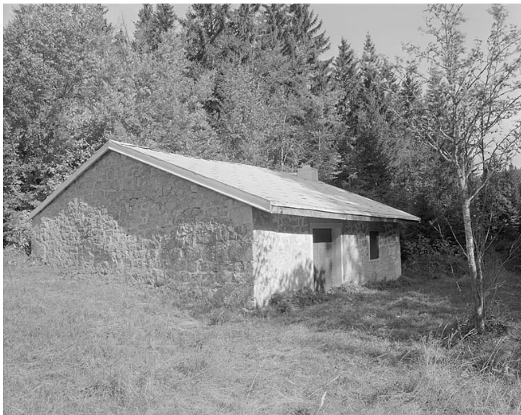
Face sud-ouest et façade antérieure.
