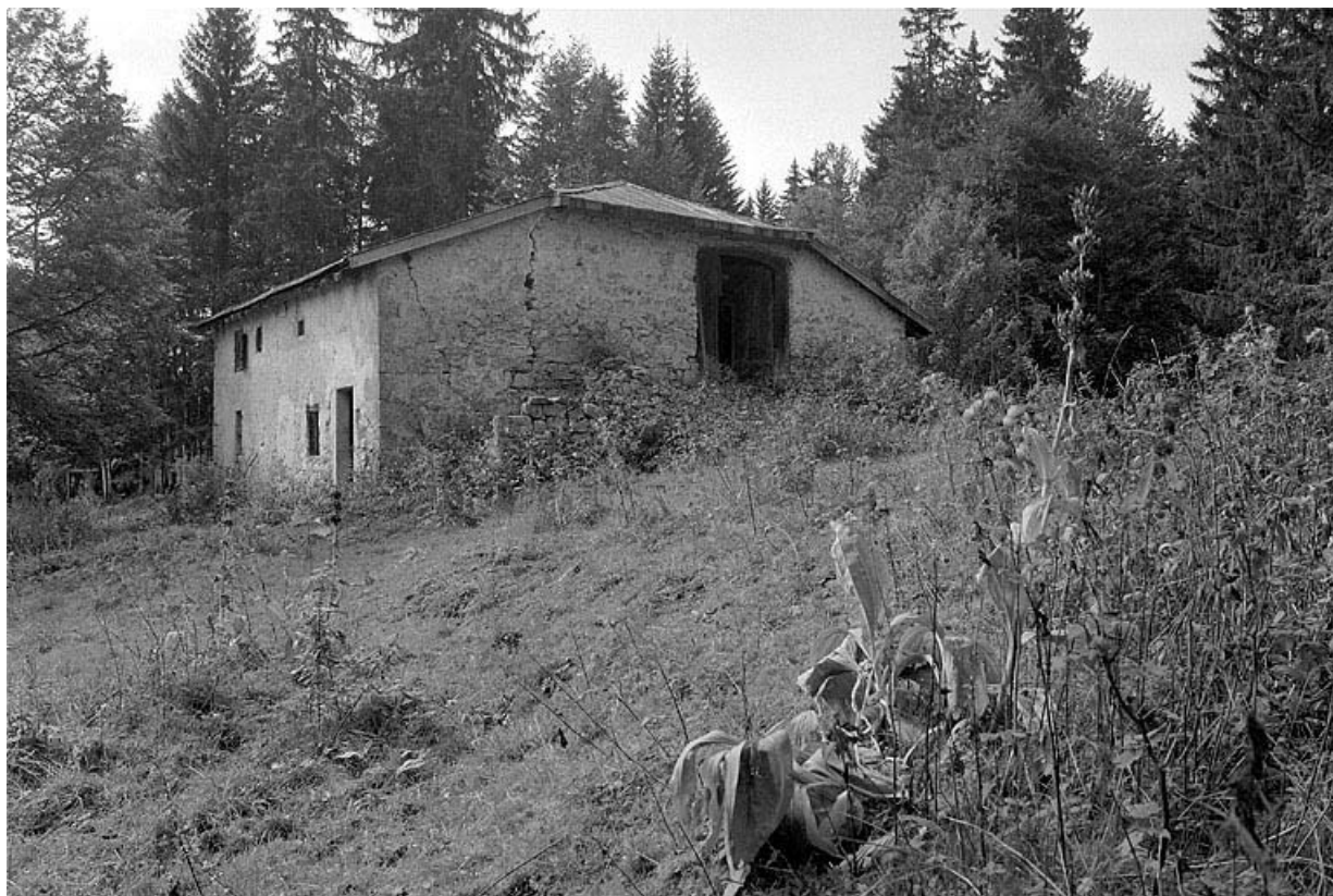
Face nord-est et grange haute.
