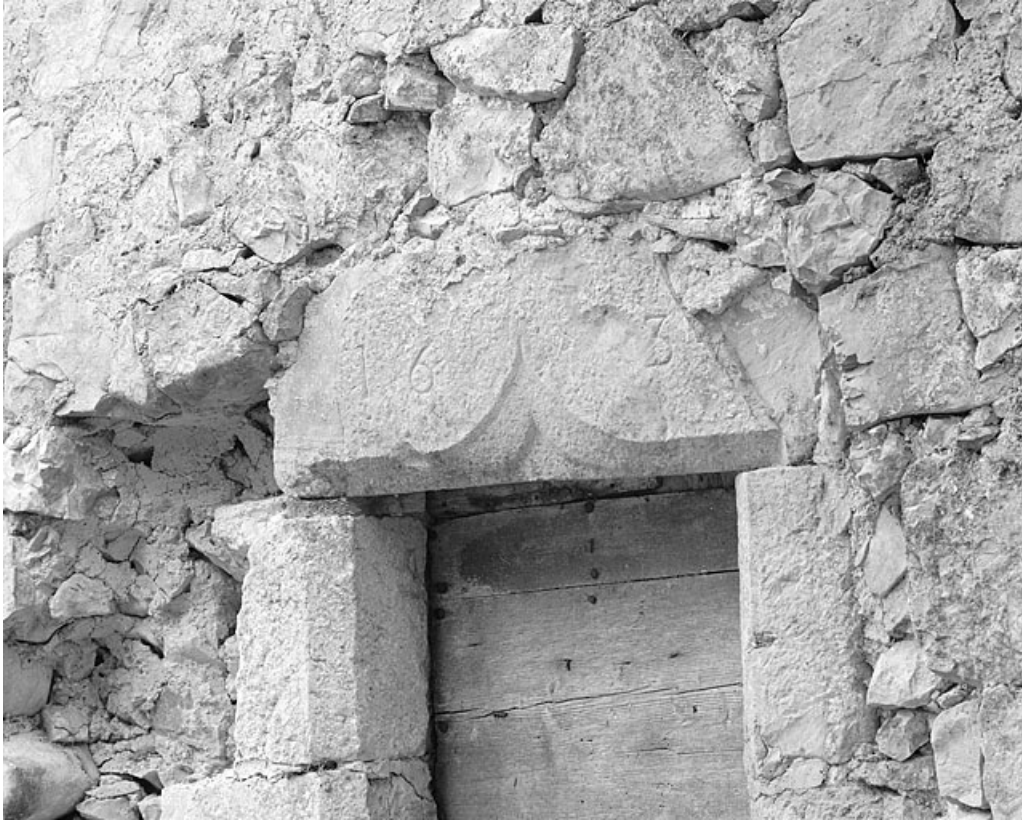
Date portée par la porte de l'étable sur la façade postérieure.
