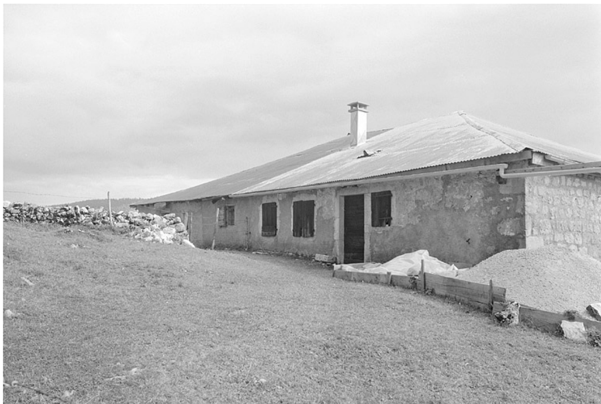
Façade postérieure, vue de trois quarts droit.
