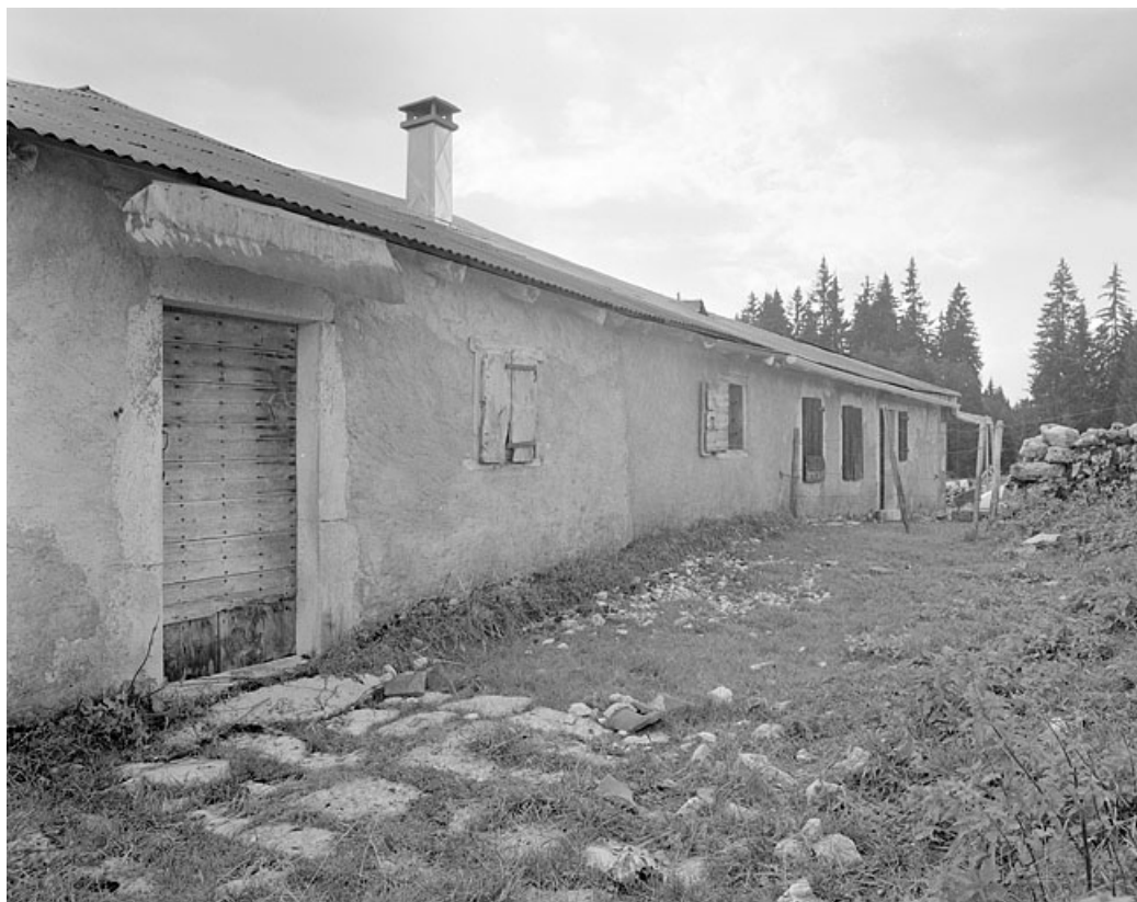
Façade postérieure, vue de trois quarts gauche.
