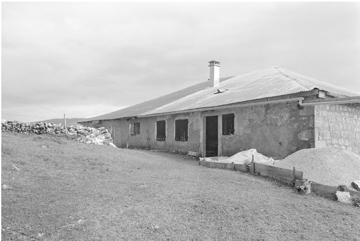
Façade postérieure, vue de trois quarts droit.
