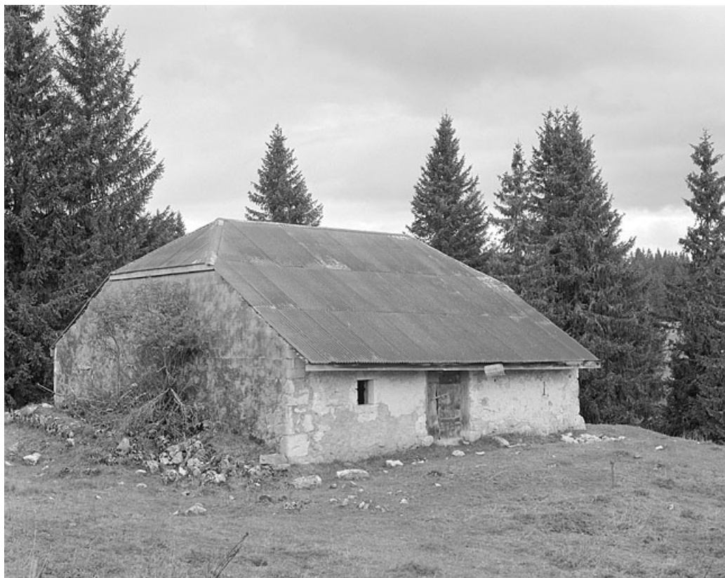
Façade antérieure et face sud-ouest.
