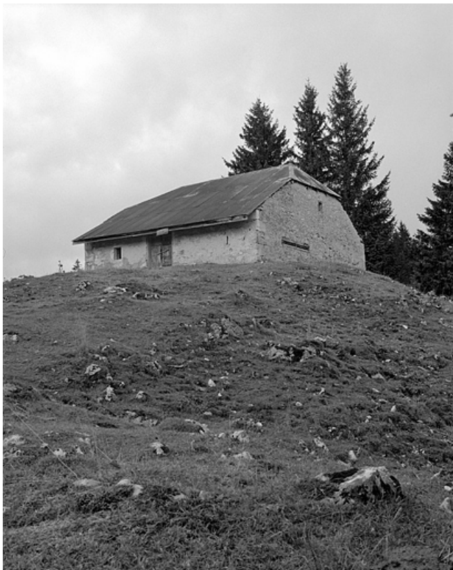
Façade antérieure et face nord-est.
