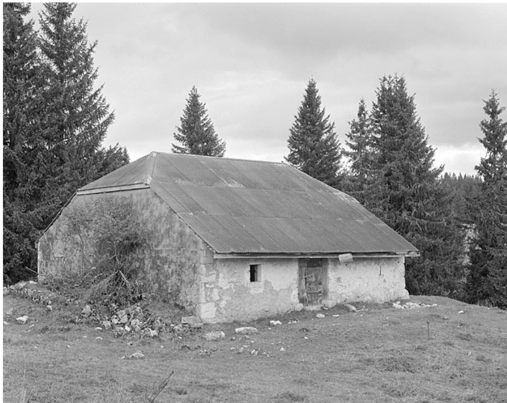
Façade antérieure et face sud-ouest.
