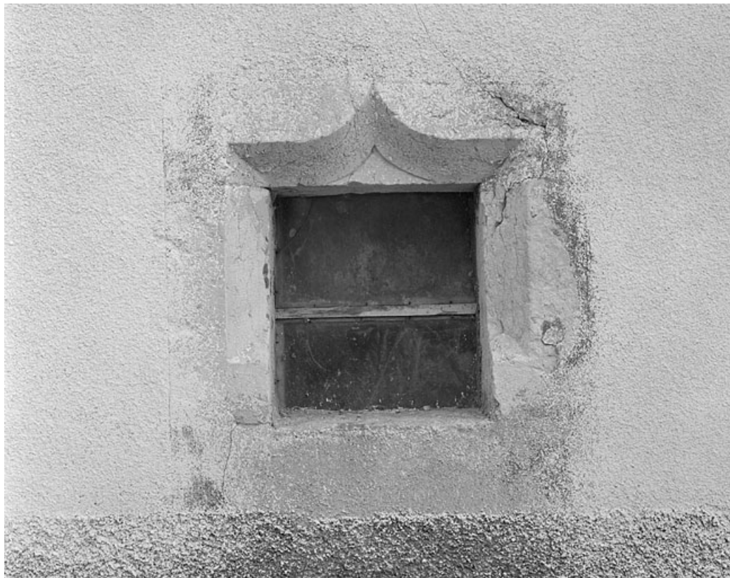
Fenêtre avec linteau en accolade sur la façade postérieure.
