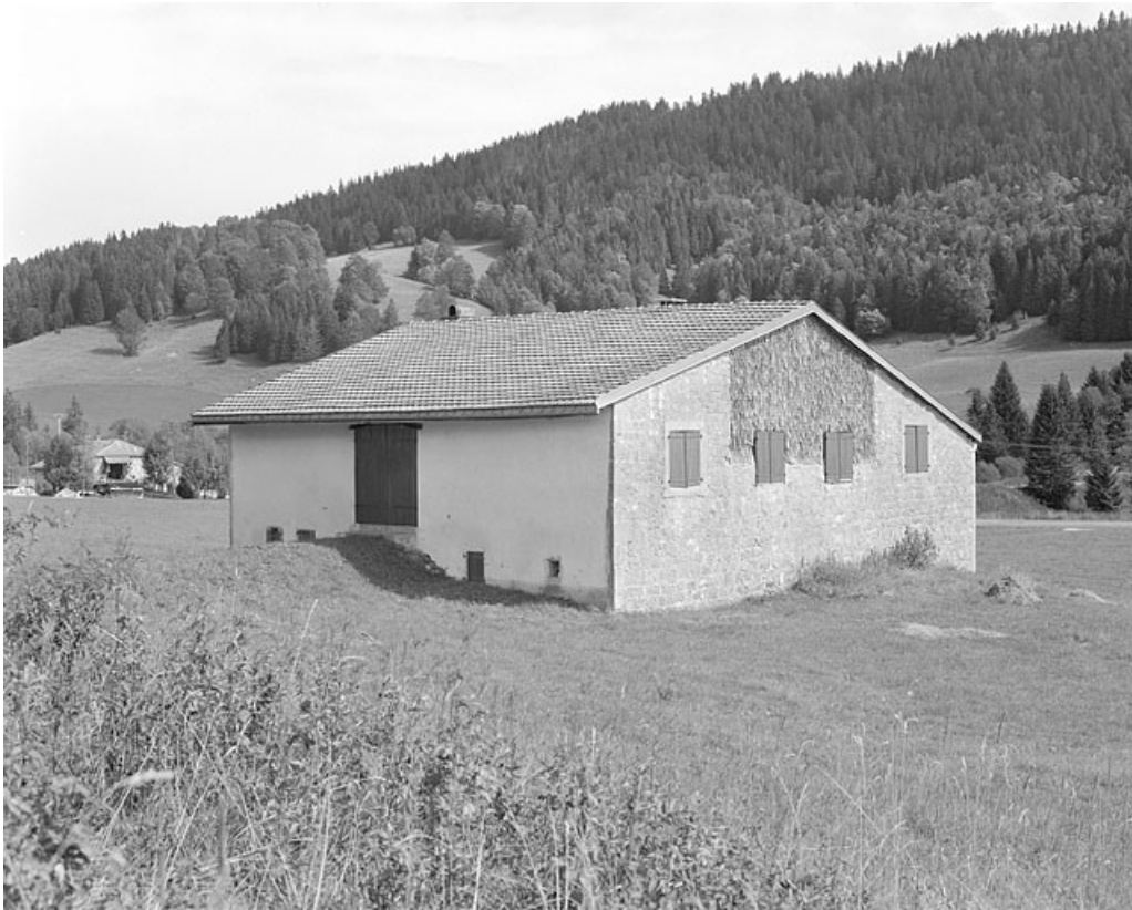
Façade postérieure et face sud-ouest.
