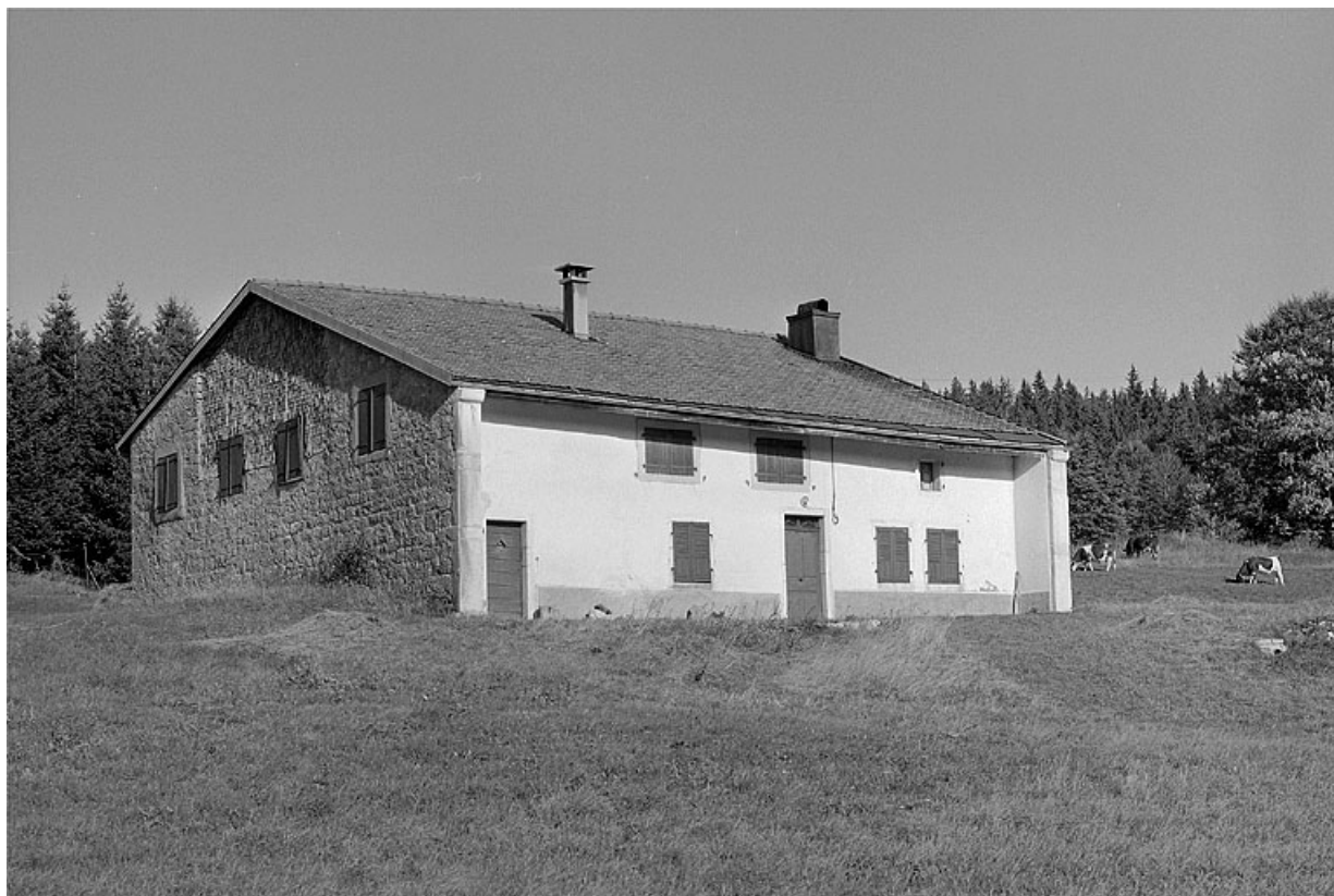
Façade antérieure et face sud-ouest.
