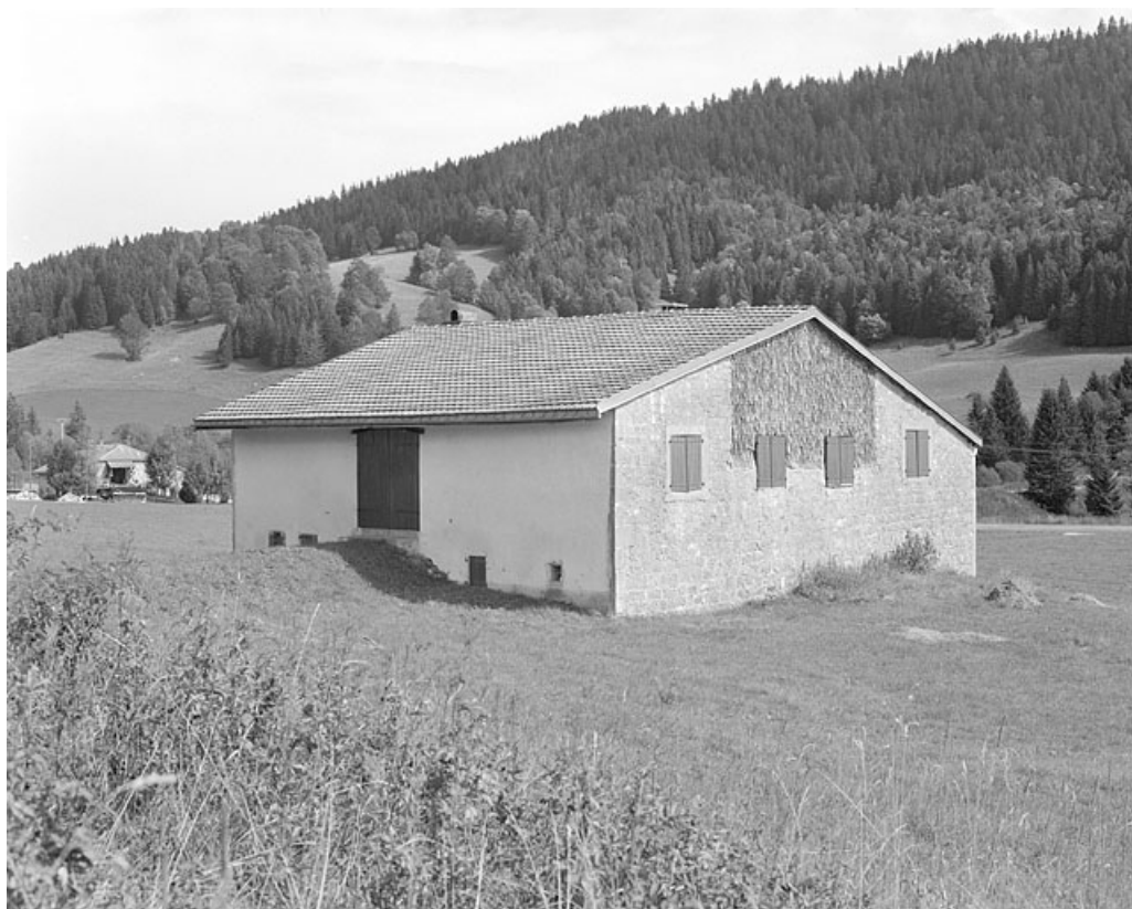
Façade postérieure et face sud-ouest.
