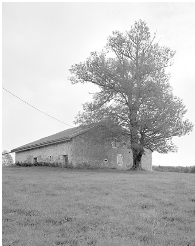
Face sud-ouest et façade postérieure.
