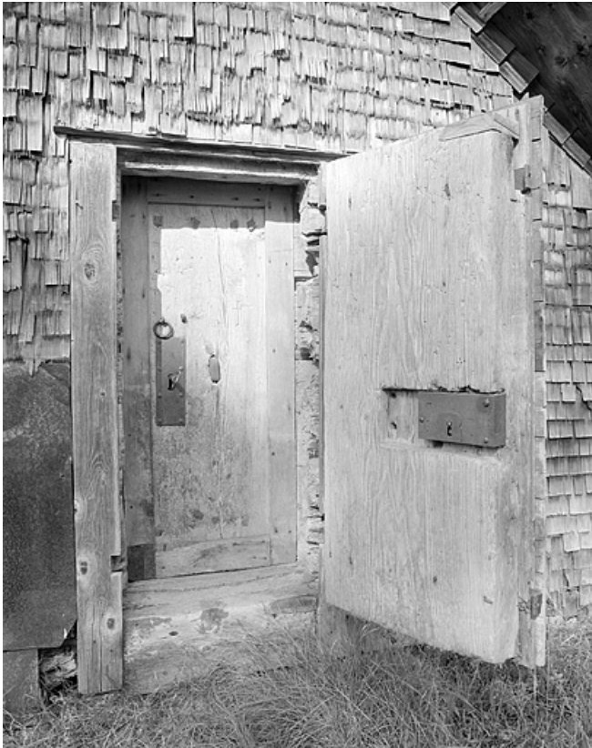
Double porte d'accès du grenier fort.
