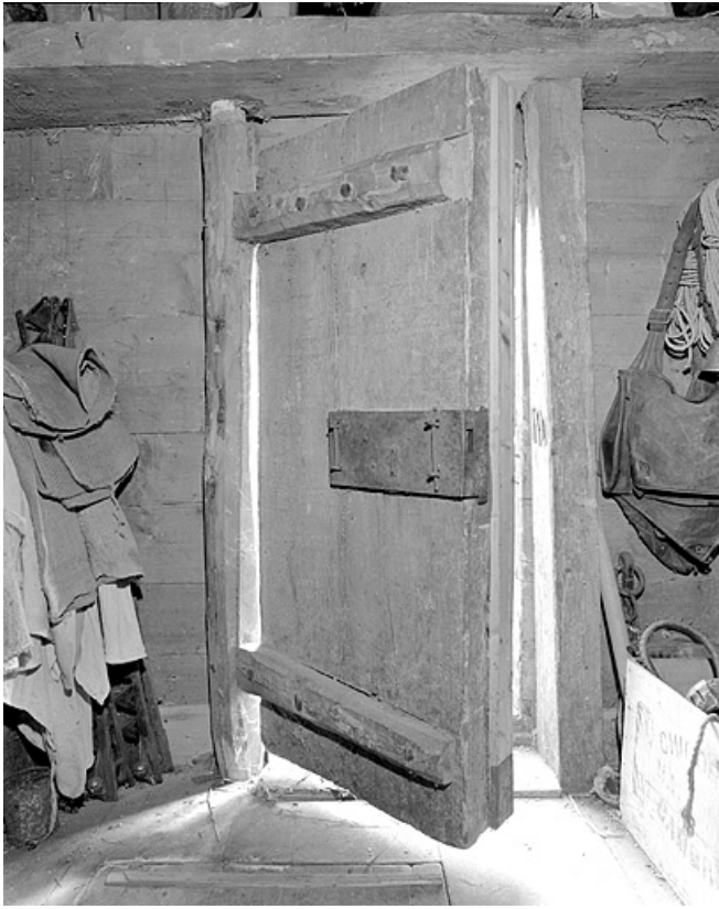
Porte intérieure du grenier fort. 39, Lamoura chemin Sous la Roche
