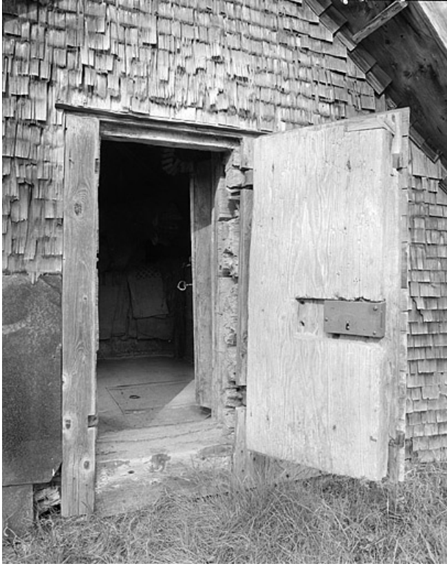
Les deux portes du grenier fort ouvertes.
