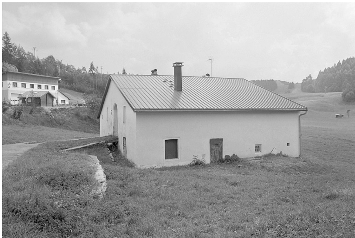
Façade postérieure et face nord-est.
