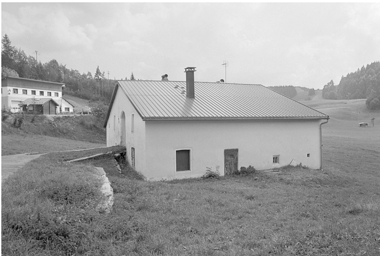
Façade postérieure et face nord-est.
