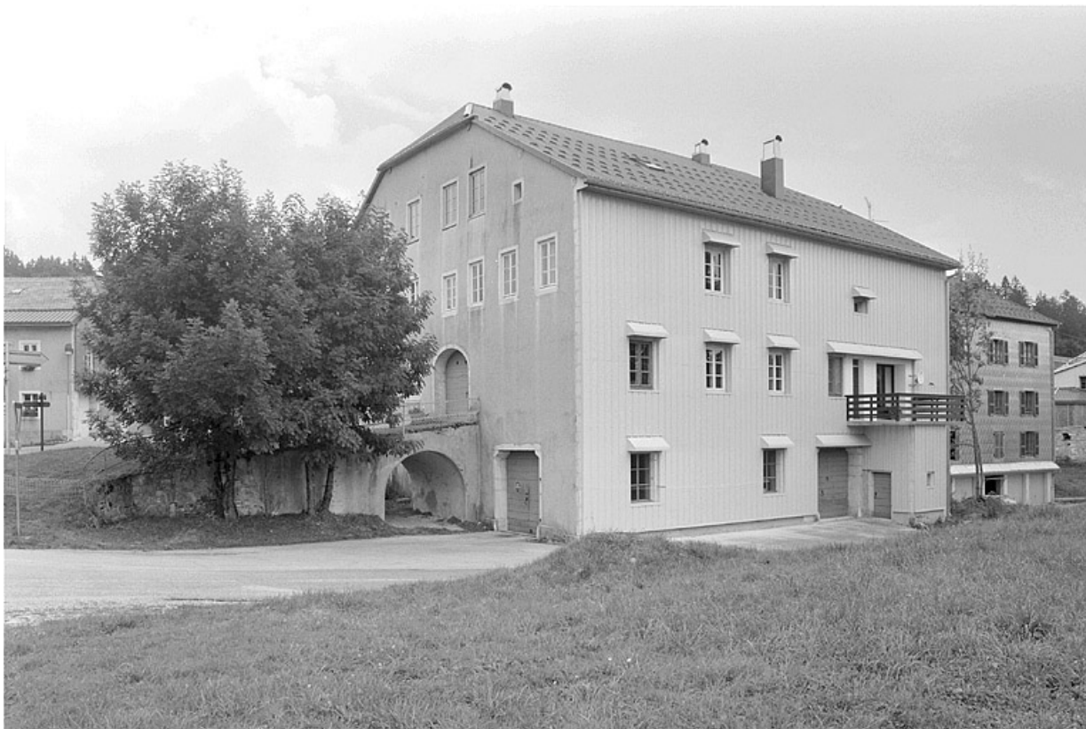
Façade postérieure et face nord-ouest.
