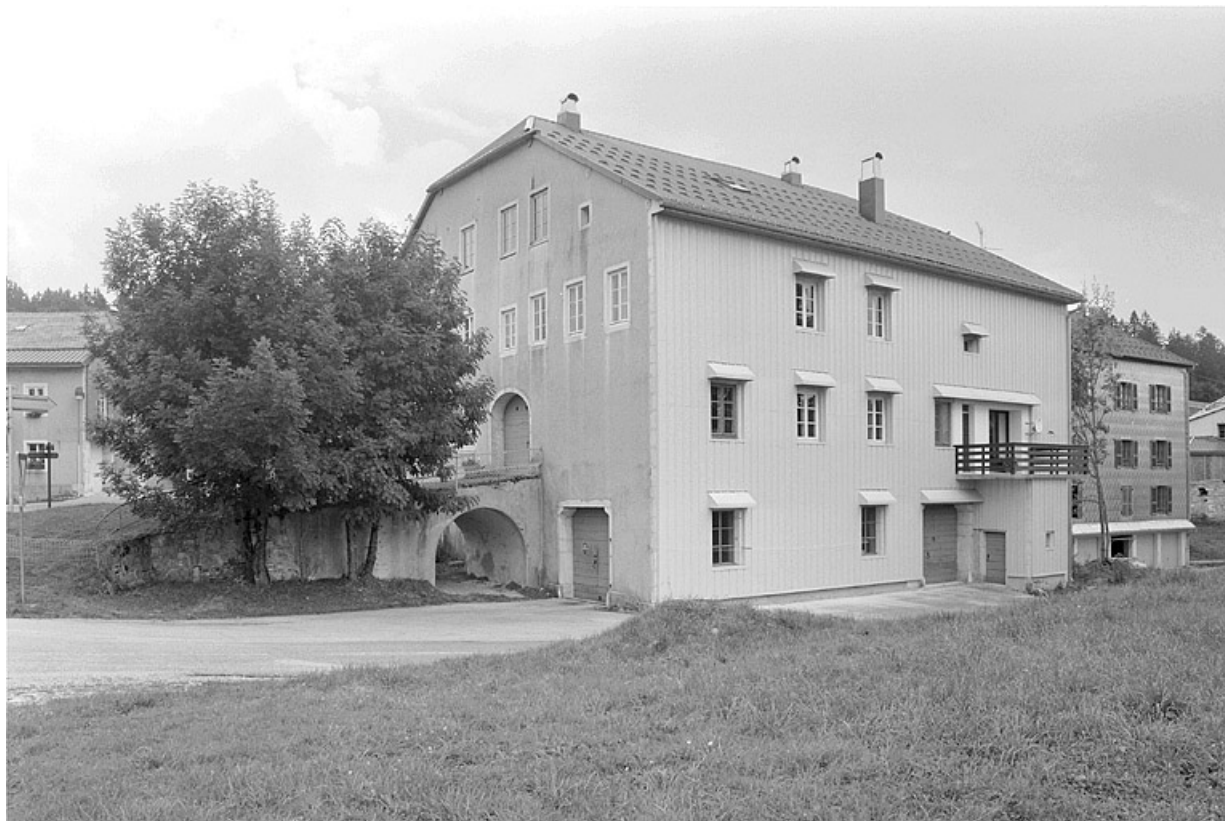
Façade postérieure et face nord-ouest.
