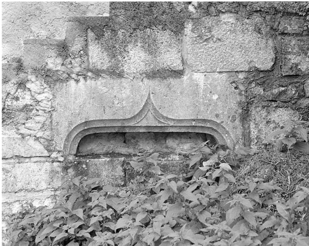
Linteau en accolade employé.
