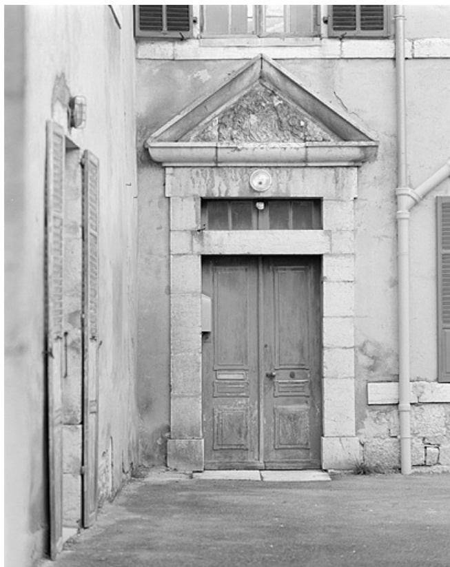
La porte d'entrée de l'ancien presbytère.
