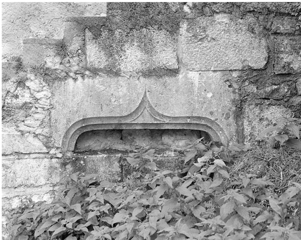
Linteau en accolade employé.
