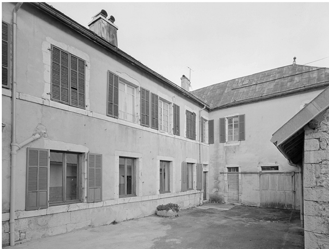
Cour intérieure : logis de la cure.
