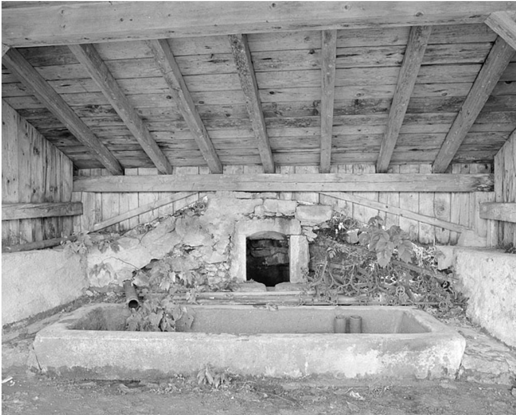
Bassin de l'abreuvoir et accès à la citerne.
