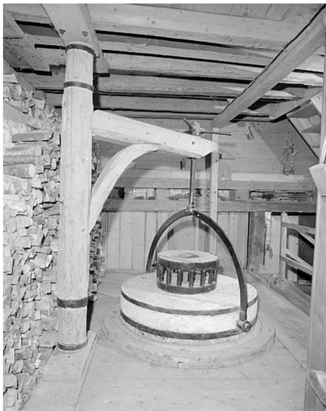
Meule gisante en place, potence pour habiller la meule.
