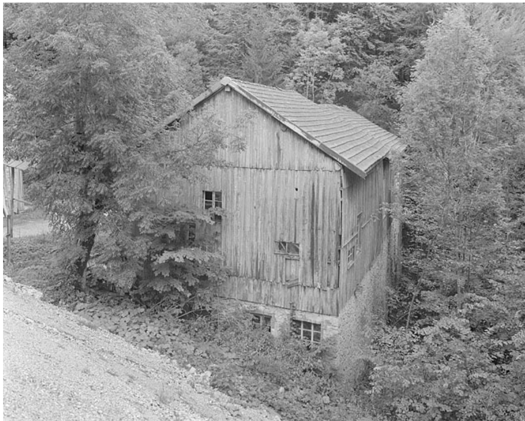
Façade postérieure et face droite de la scierie.
