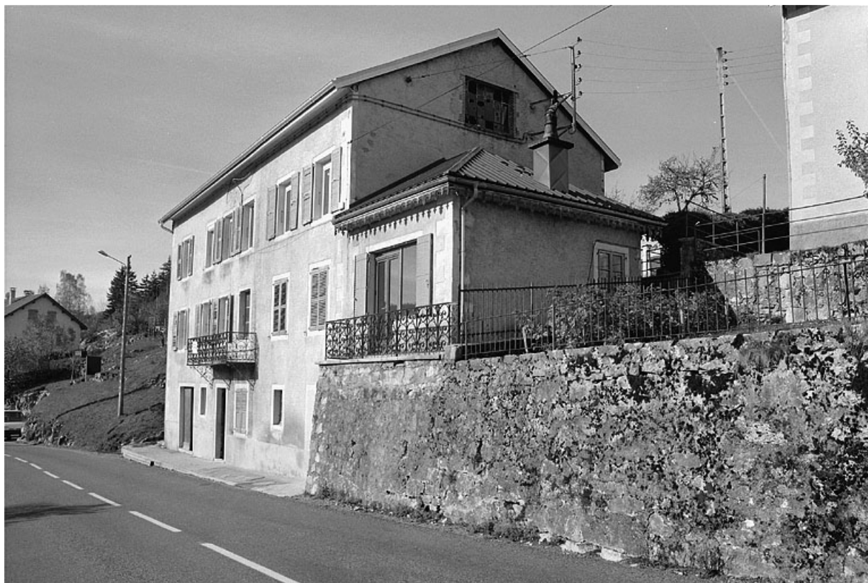
Façade antérieure et face nord-est.
