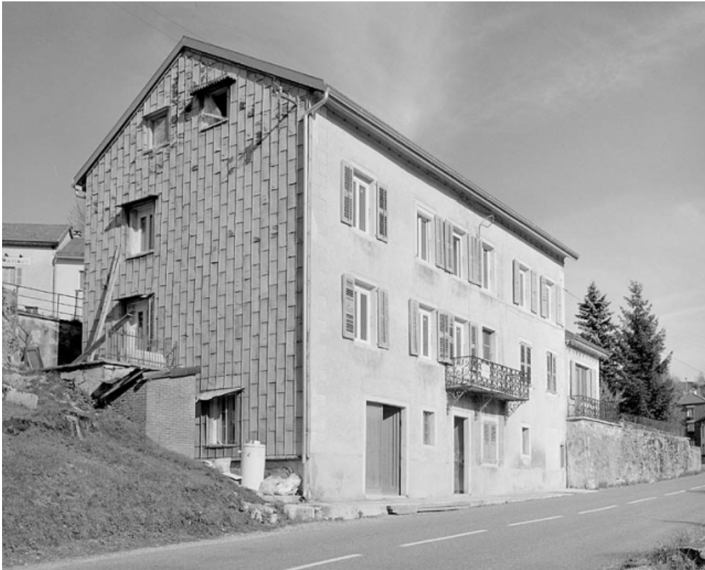
Façade antérieure et face sud-ouest. 39, Septmoncel Genève
