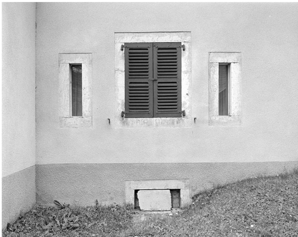
Détail des fenêtres de la fromagerie sur la face nord-est.
