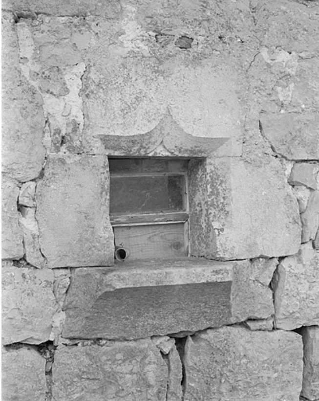
Fenêtre en accolade sur la façade postérieure.
