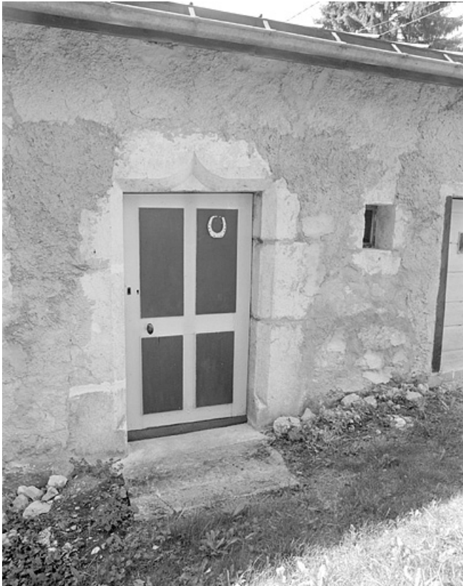
Porte d'accès au logis avec linteau en accolade.
