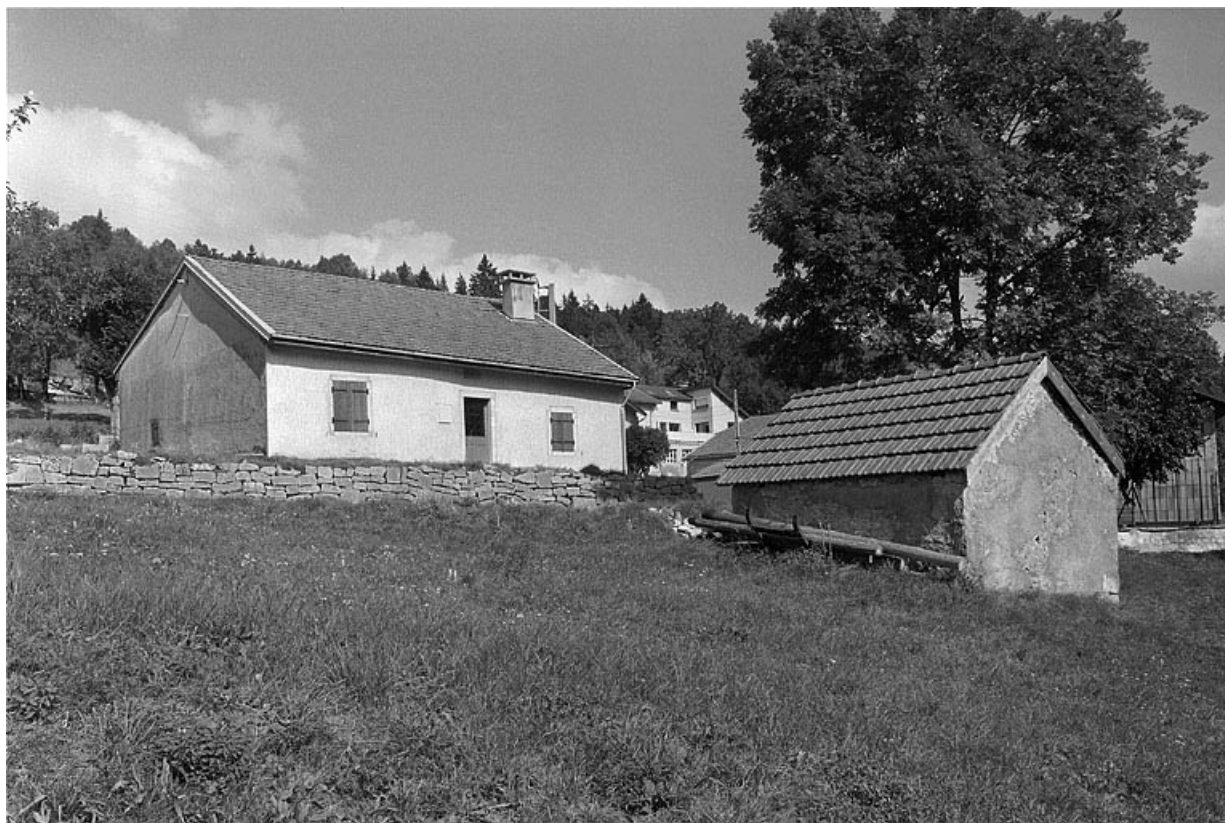
Vue générale de la ferme et de son grenier fort.
