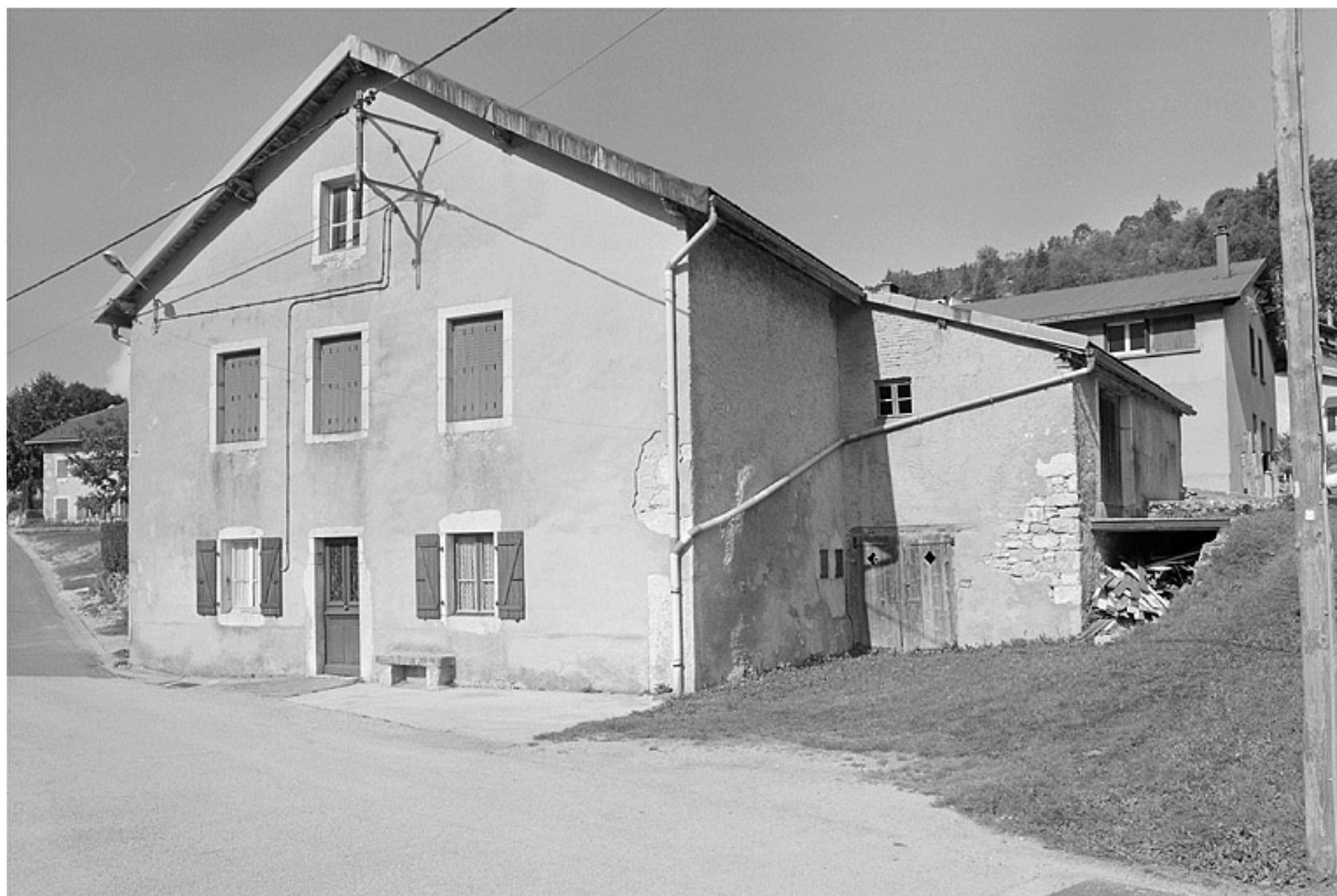
Façade d'une ancienne ferme de Montépile, modifiée en 1816.
