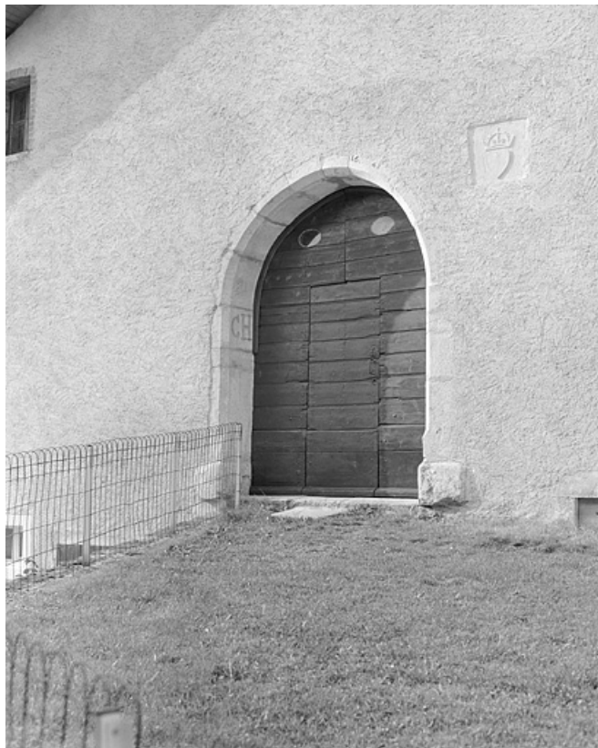
Porte de grange et armoiries d'une ferme à Montépile. 39, Septmoncel
