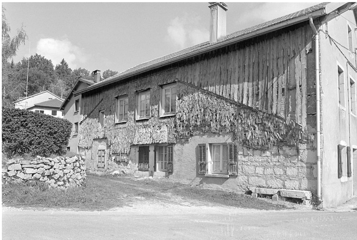
Façade d'une ancienne ferme retournée à Montépile.
