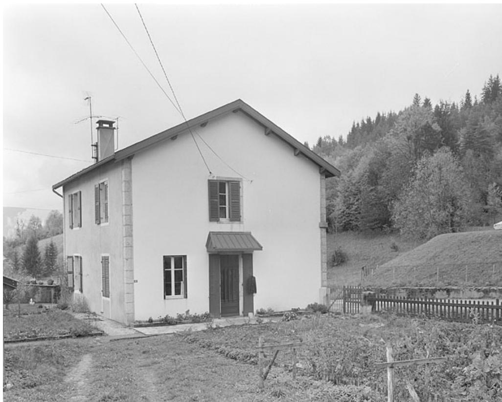
Façade postérieure et face nord-est.
