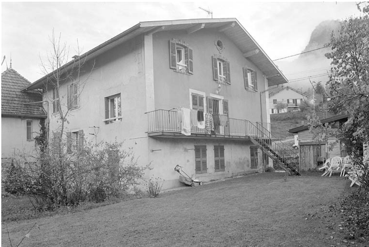
Face sud et façade postérieure du bâtiment principal.
